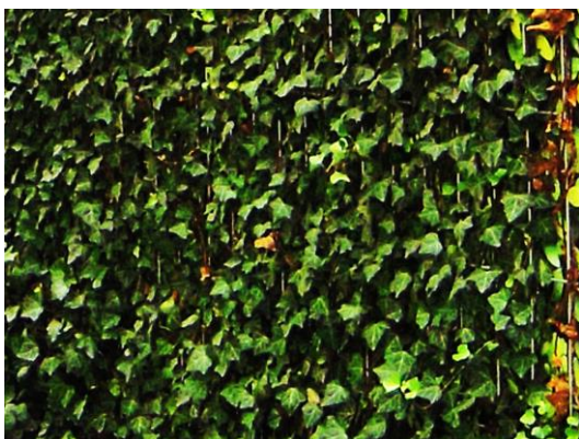
Figure 15 Photo d'une façade verte continue
