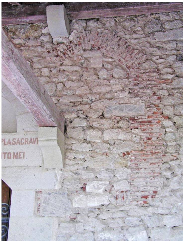
Fig. 28. Germigny-des-Prés. Arc en mitre retrouvé sous les enduits extérieurs du mur sud. c.a. 11 e siècle. (SAPIN, CH. et BÜTTNER, S., 2019, p. 31.)
