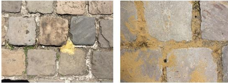
Figure 19 - illustration des modalités de la variables qualitative « type de joint ». Joint rigide dégradé (à gauche) et joint souple (à droite)
