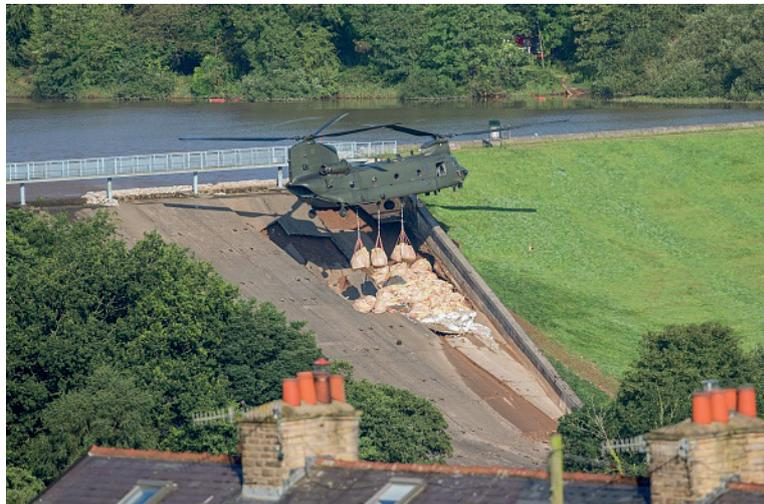
**Figure 1.8.** Photo d'un renforcement de barrage sur le point de c  der en Angleterre
