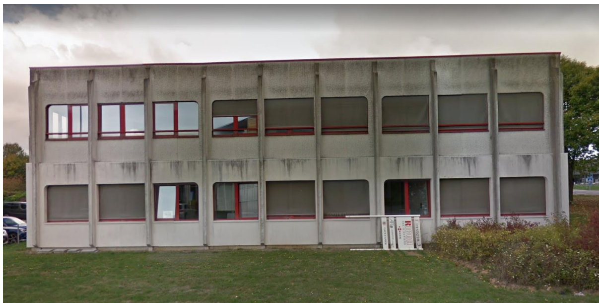
Figure 4-1 Extension du bâtiment Marie Curie à Wavre dit "le cube"
