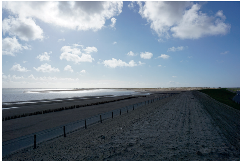
Figure 1.25 - Travaux récents de rehaussement de digues. L'enherbement de la digue n'est pas encore réalisé, côté ouest de l'île de Texel.
