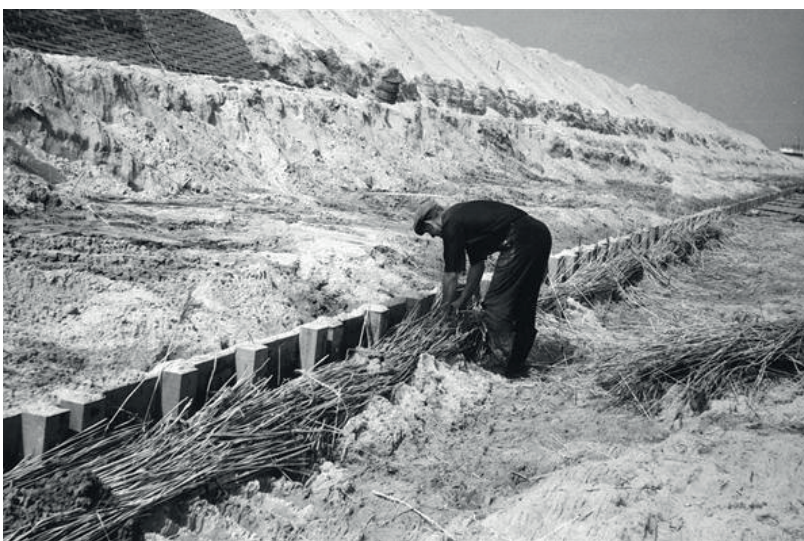
Figure II.3 - Perméabilisation de la digue à proximité du polder d'Eijerland en 1967 (Texel). Source: Rijkswaterstaat
