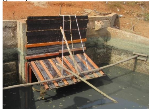
Figure 9 – Gauche : Schéma de construction de vannes à clapet sur l'ouvrage de Séguéma. Droite : Photo de la construction finale.
