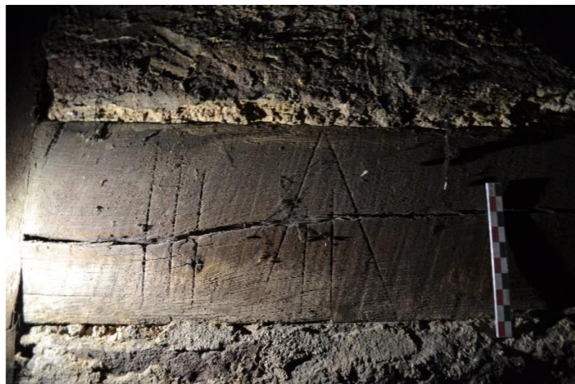
65. Marques d'assemblage sur une entretoise du 3 e étage 65 :
