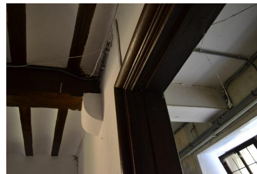
124. Première poutre sur corbeau et son prolongement 124 :
