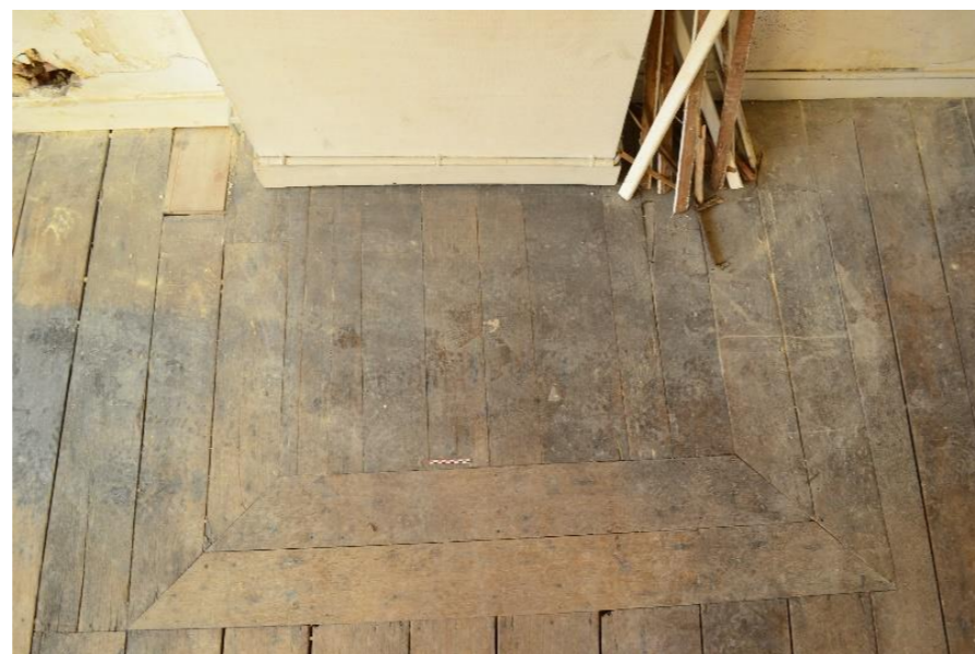
151. Trace d'un seuil de cheminée 151 :
