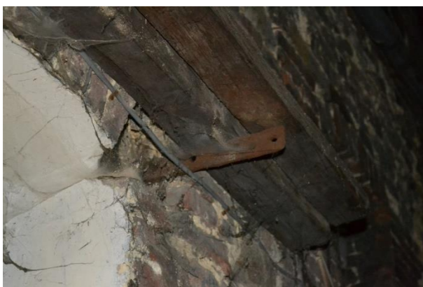
72. Ancre orpheline du mur pignon 72 :
