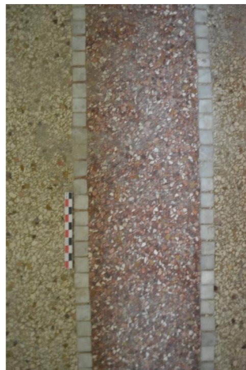
123. Revêtement de sol en granito 123 .
