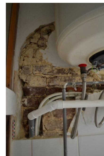
145. Sondage dans le corps de cheminée 145 :
