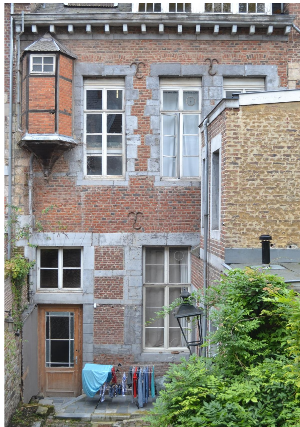
92. Façade nord de la maison à rue 92 :
