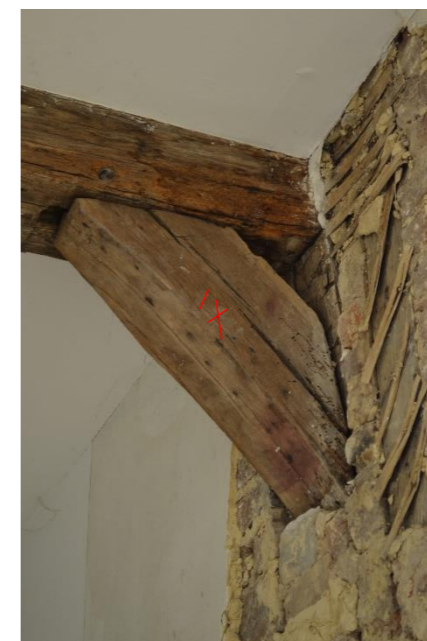
152. Lien entre poutre apparente et pan de bois 152 :
