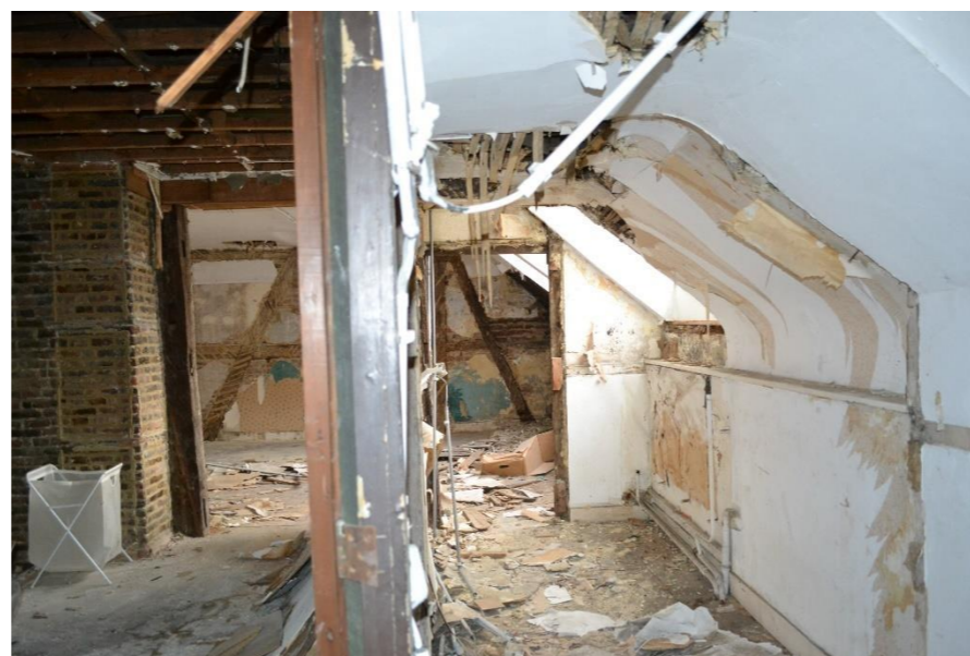
157. Couloir menant au local L.A.02.02 157 :
