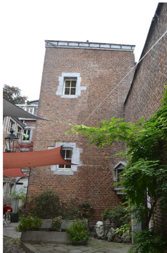
162. Baies percées dans le M.B.sud 162 :
