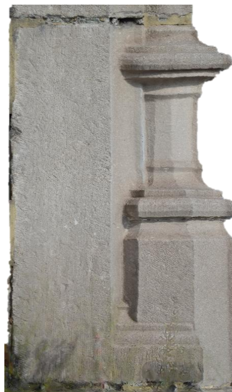
89. Façade à rue - Base de colonnette gothique 89 :
