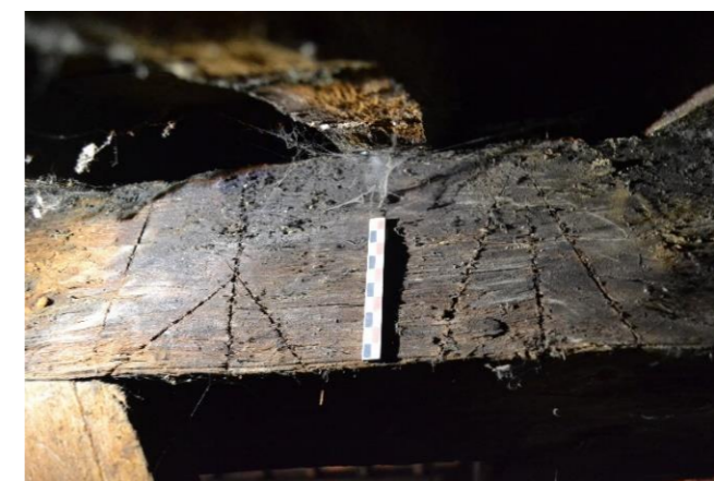
78. Assemblage des pannes inférieures 78 :
