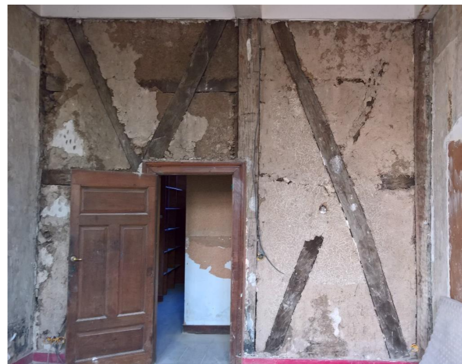
170. Partie du pan-de-bois interne à la maison à rue (16a) 170 :
