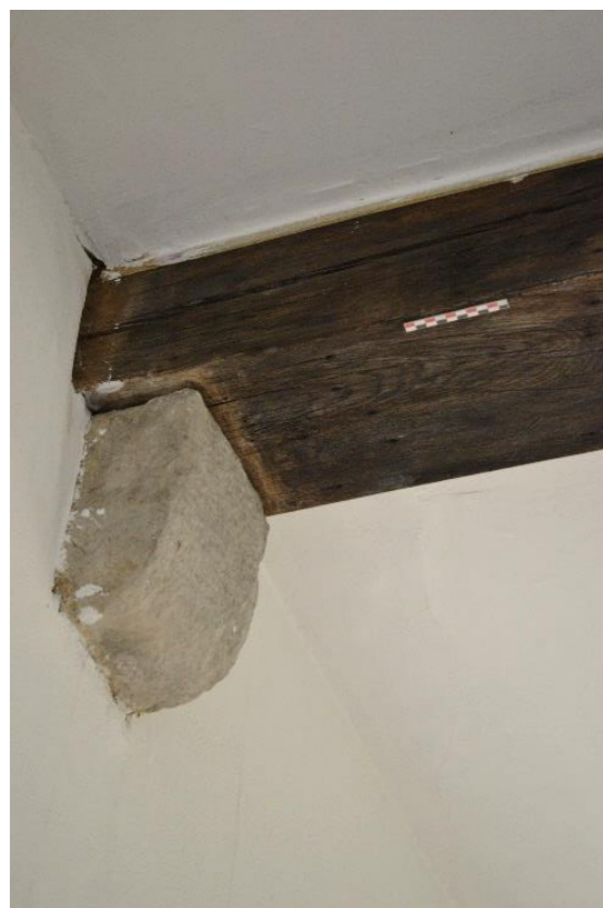
139. Première poutre sur corbeau 139 :
