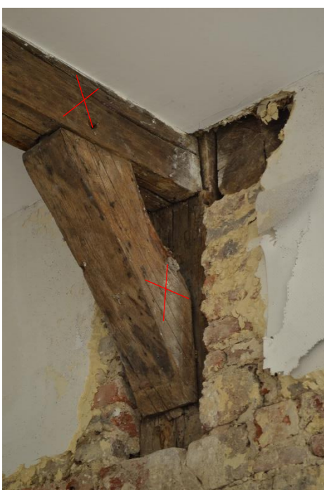
153. Lien entre poutre apparente et pan de bois 153 :
