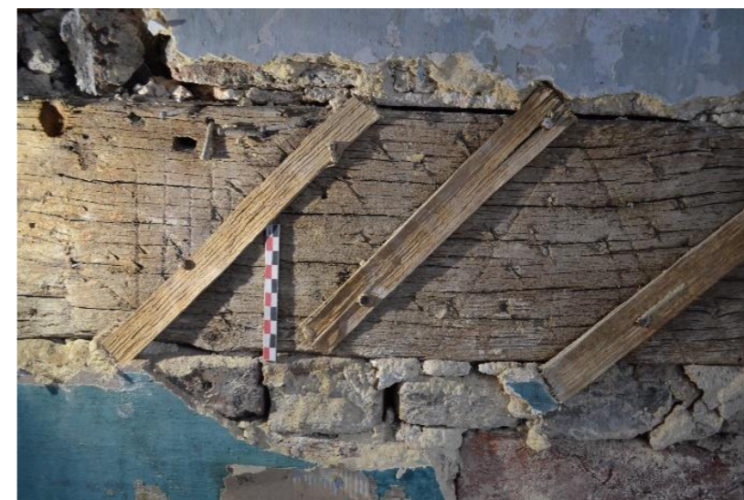
66. Marques d'assemblage sur une entretoise du 2 e étage 66 :
