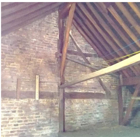
64 : Vue de la partie haute du pan-de-bois mitoyen 64 :
