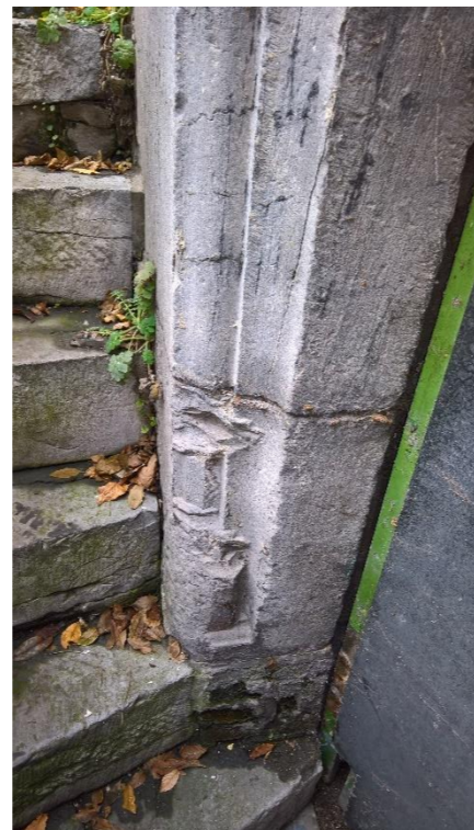
84. Accès de la cave – Piédroit gauche 84 :
