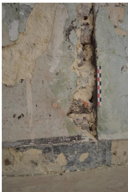
146. Sondage dans le corps de cheminée 146 :
