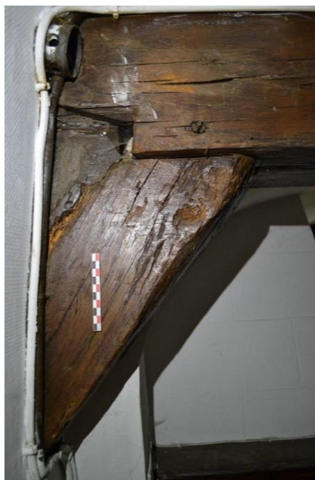
126. Lien de la seconde poutre au mur de refend 126 :
