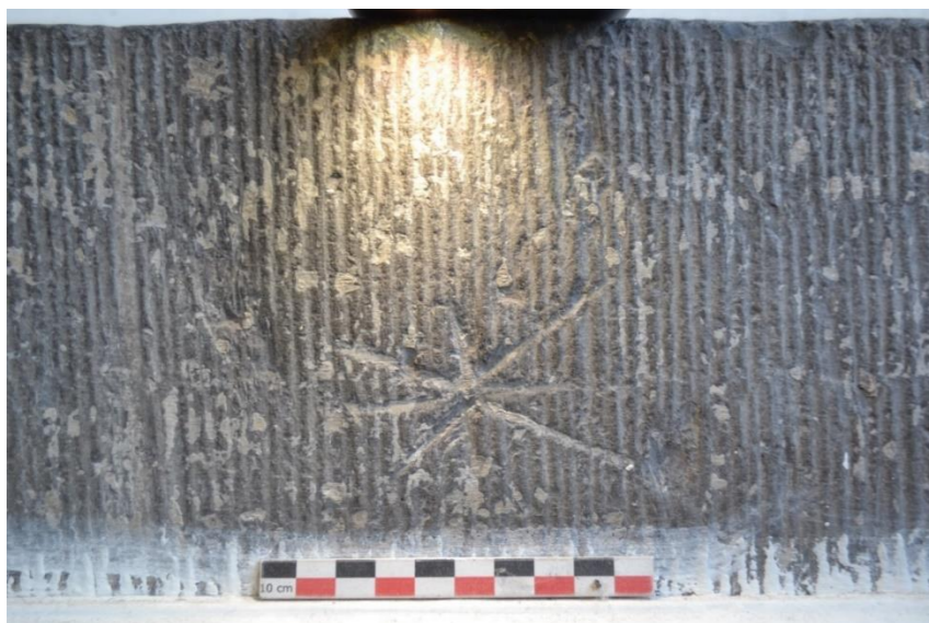
137. Appui de fenêtre – signe lapidaire 137 :
