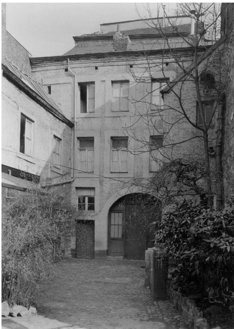
32. Cour du n° 18. À droite, façade ouest de la maison Libotte 32 :
