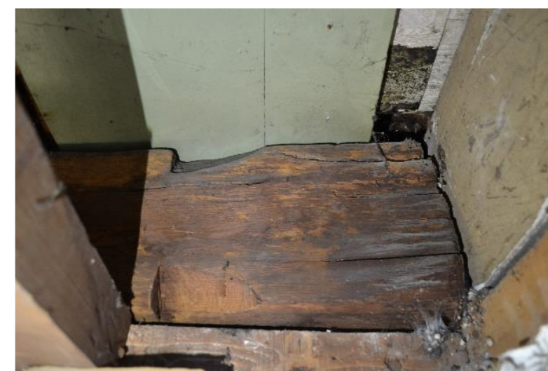
62. Trace de levage sur une poutre 62 :
