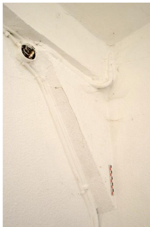
133. Console soutenant une poutre 133 :
