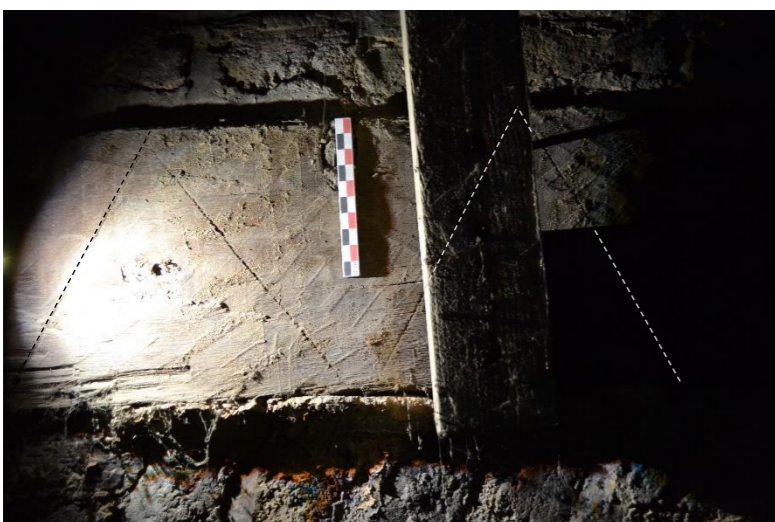
67. Marque énigmatique sur la poutre du 3 e étage 67 :
