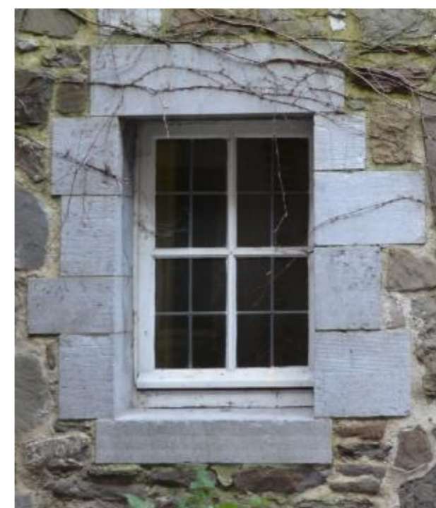
163. M.A.ouest : vue extérieure d'une baie 163 :
