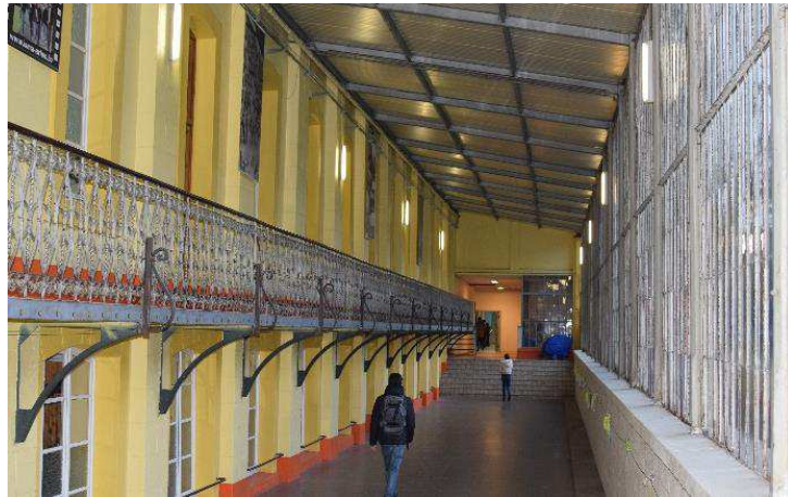
Figure 17 - Passerelle permettant d'accéder à la classe C305 (photo de l'auteur)
