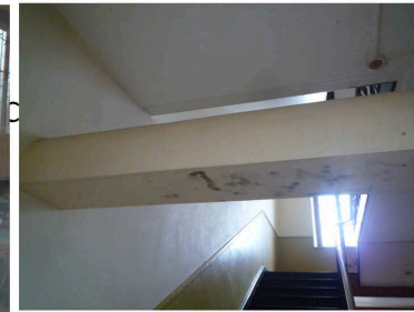
#10 POUTRE (ESCALIER B)
