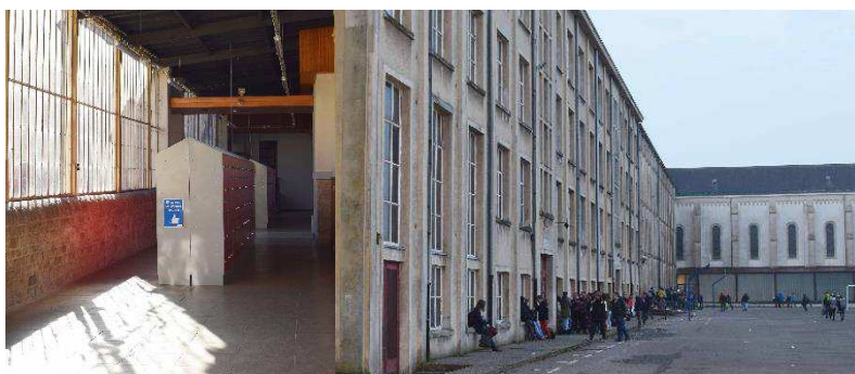
Figure 22 - A gauche, hall principal et à droite, vue de la cour sur le bâtiment B
