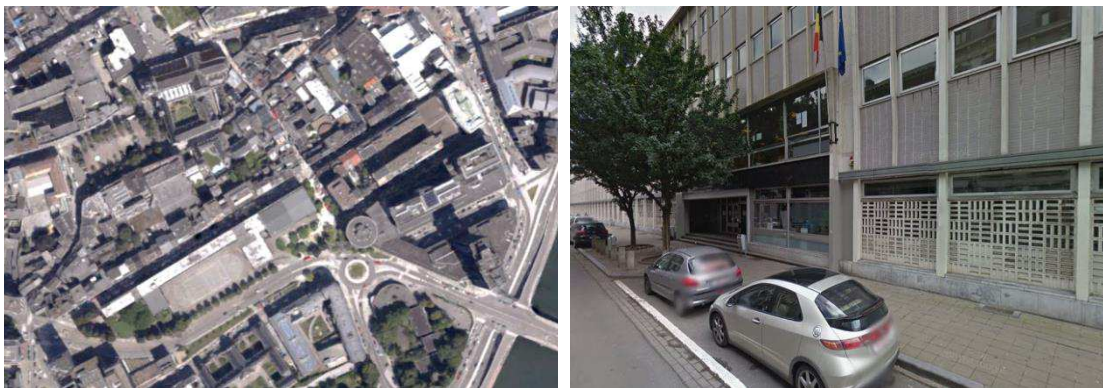
Figure 11 - Implantation de Liège 1 et photo de la façade (google street view)
