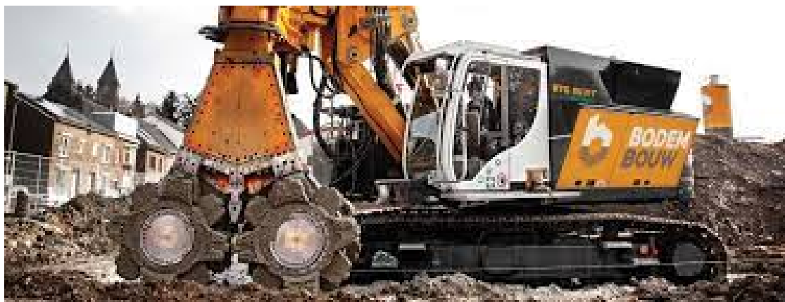
FIGURE 34 – Machine permettant de réaliser des panneaux soil mix [ https://www.bodembouw.com/en/cutter-soil-mixing ]
