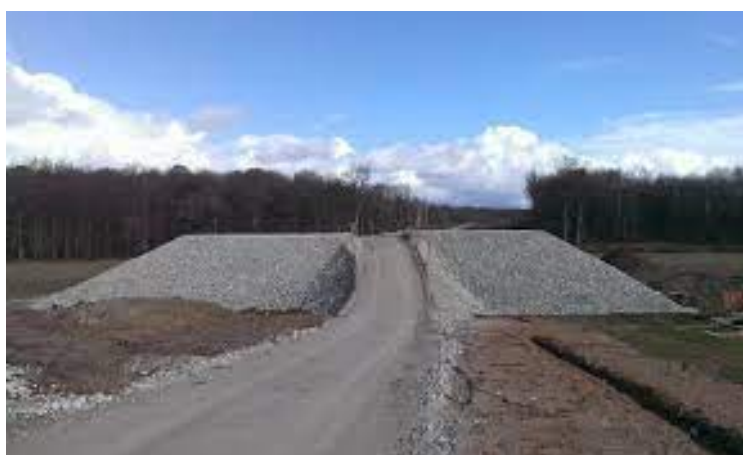
FIGURE 13 – Préchargement à l'aide d'un remblai
