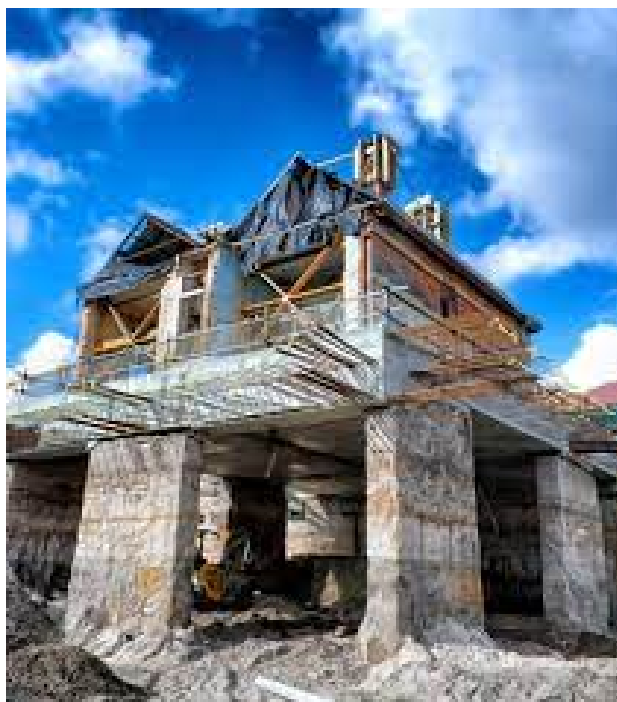
FIGURE 37 – Utilisation du cutter soil mixing pour soutenir un bâtiment classé en Australie [Bauer, 2014]
