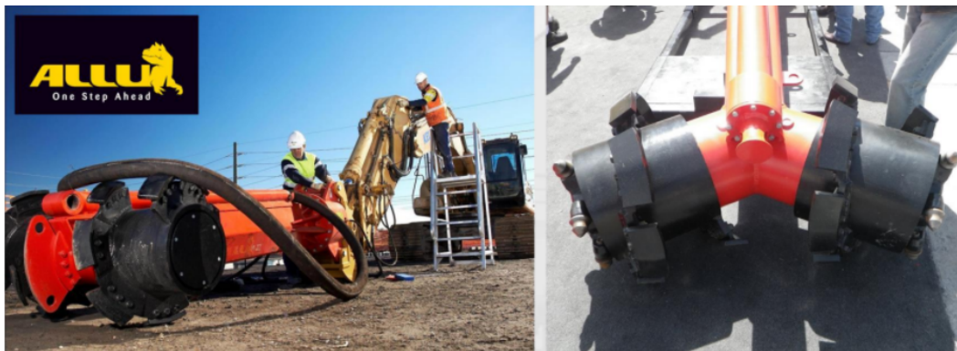
FIGURE 39 – Outil de stabilisation de masse [Denies, Huybrechts, 2013]
