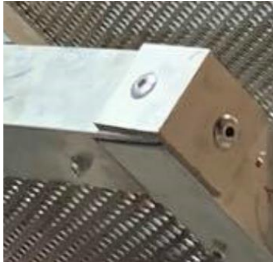
Figure 41 Solidarisation entre cornières avec rivets
