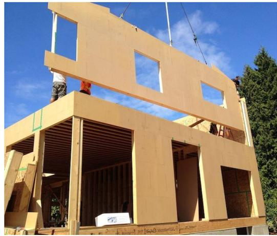
Figure 42 : Construction en panneaux massifs [Mai14].
