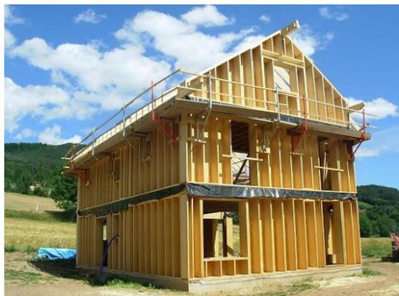
Figure 39 : Construction en ossature bois [Egb17].
