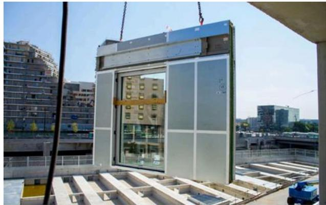
Figure 31 : Panneaux de bardage [Sch20].
