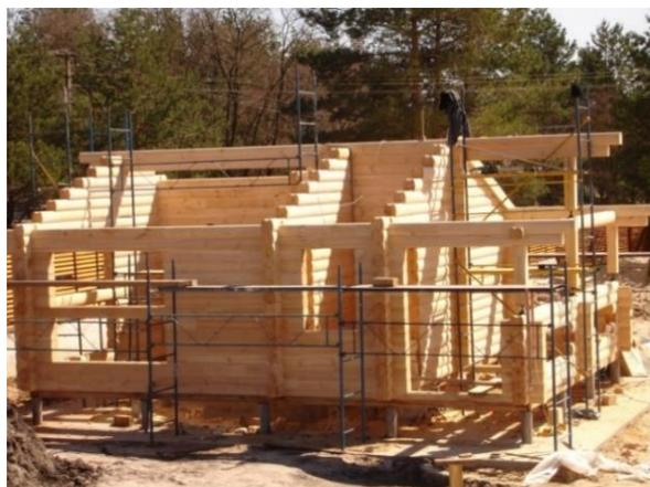
Figure 41 : Construction en bois massif empilé [BW15].
