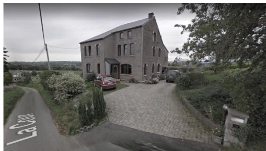
Figure 51 - Maison unifamiliale type du PLP de Charneux
