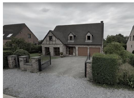
Figure 36 - Façade typique du PLP de Saint-Hadelin
