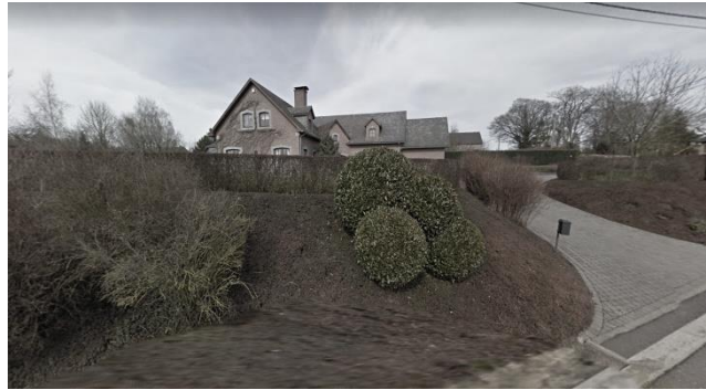
Figure 30 - Maison unifamiliale surélevée
