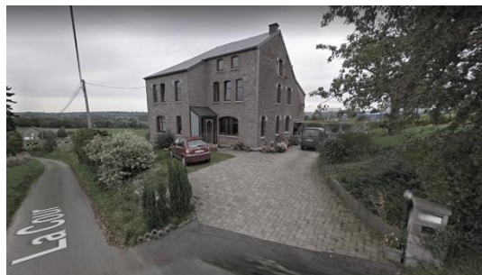
Figure 51 - Maison unifamiliale type du PLP de Charneux
