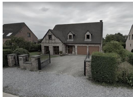
Figure 36 - Façade typique du PLP de Saint-Hadelin
