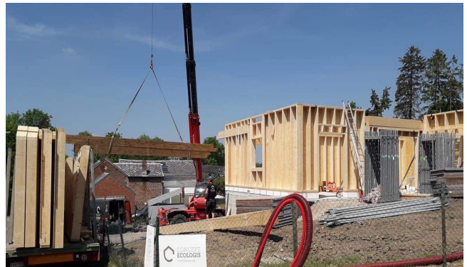
Figure 16 : Levage de murs préfabriqués en bois
