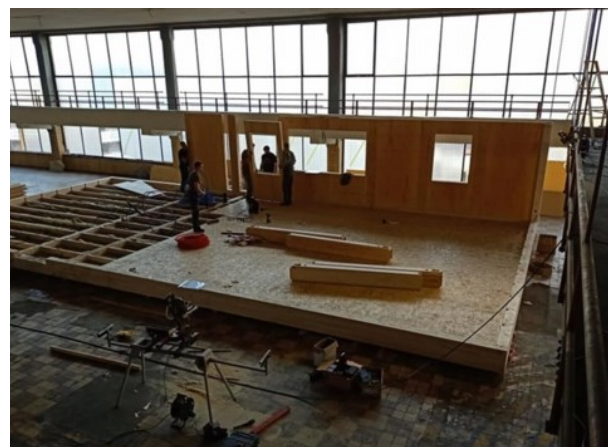
Figure 40 : Système constructif en panneaux de bois
