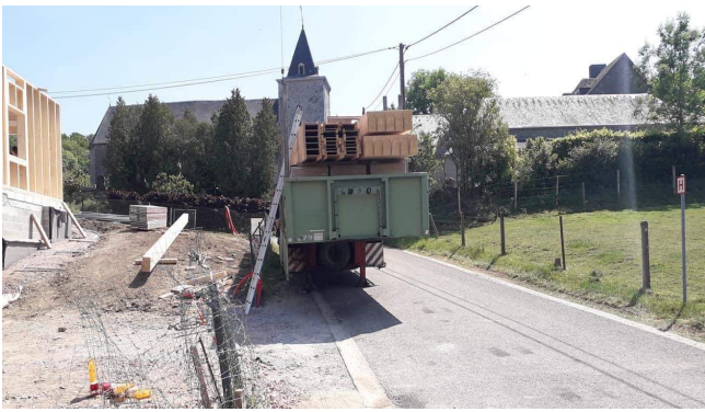
Figure 15 : Transports de murs préfabriqués sur le chantier
