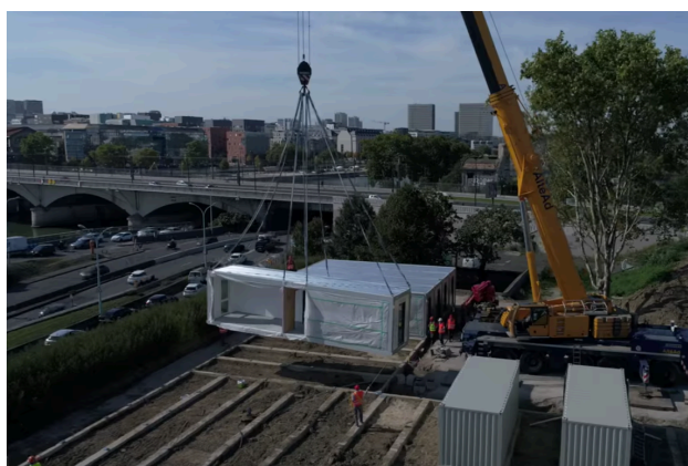
Figure 33 : CHU Bastion De Bercy - Placement des modules
