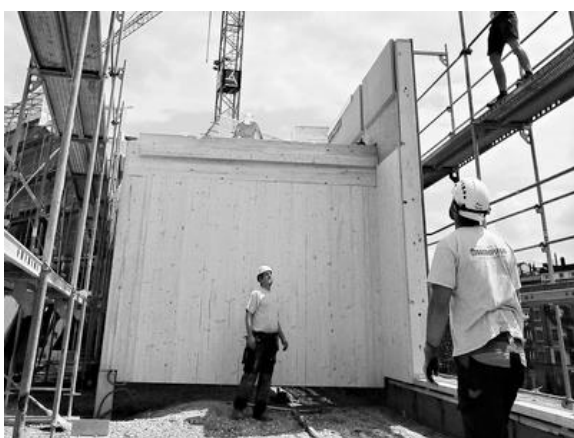
Fig.59 : Assemblage de la façade sur site
