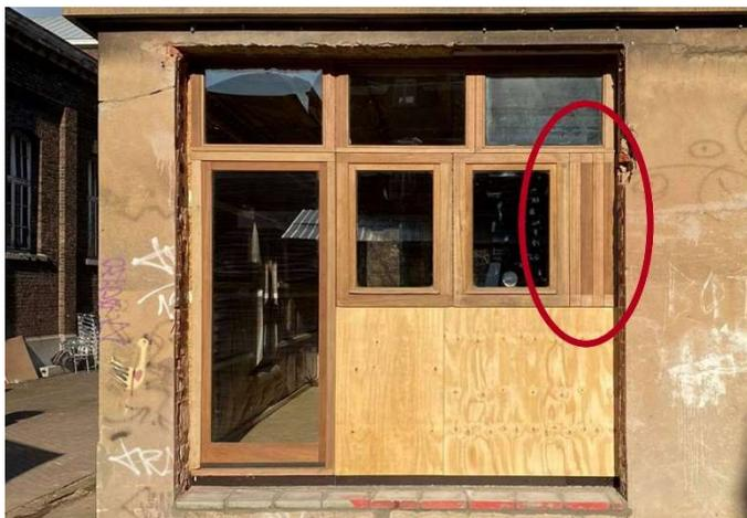
20. Paroi vitrée avec montants des châssis bois dans la partie droite de l'image.
