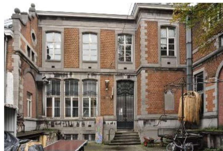
Maçonnerie de briques + pierres de taille, façades intérieur cour
