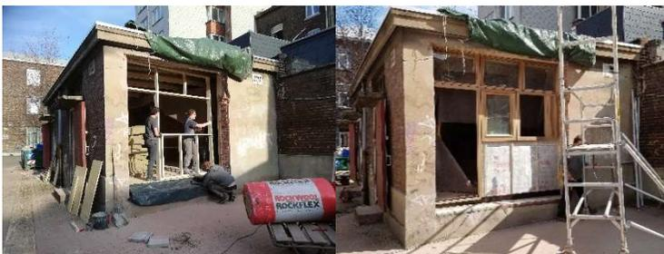
19. Pose et fixation de l'ossature et du vitrage.
