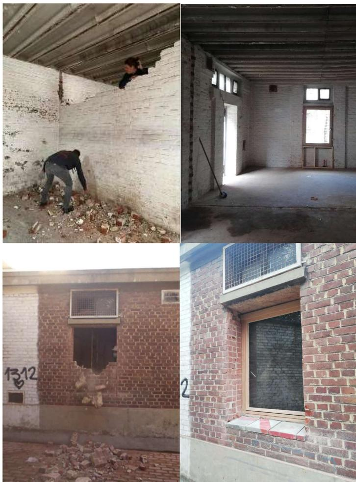
9. Déconstruction de la séparation + Percement façade Est + pose châssis de récupération.
