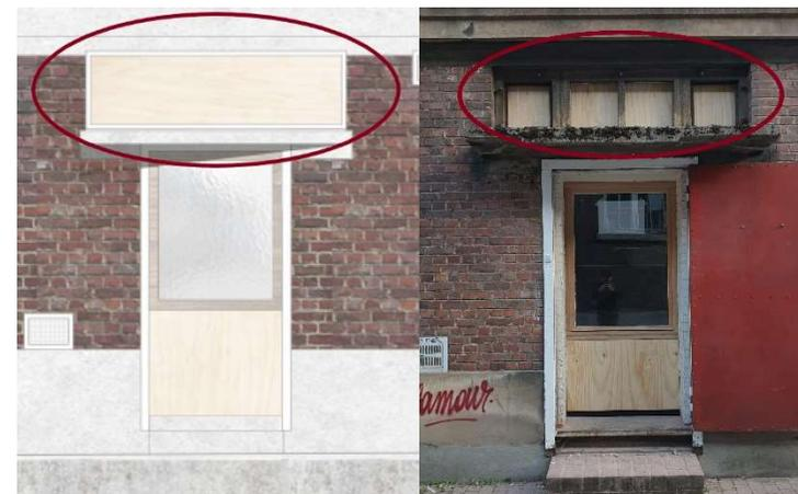
21. Ouverture projetée sans le châssis en béton / résultat fini avec conservation du châssis.
