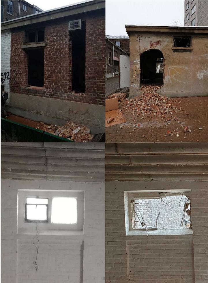
23. Châssis en béton armé existant / tentative de démolition du châssis.
