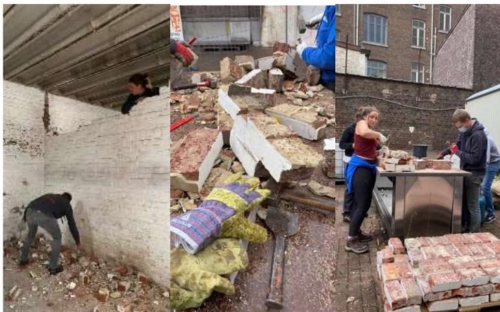
10. Déconstruction de la paroi intérieure, nettoyage et récupération des briques.
