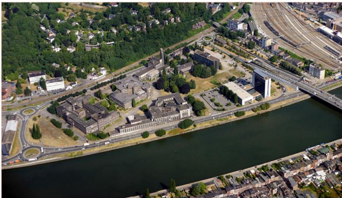
Figure 13 - photographie du site du Val Benoît avant travaux, BAUMANS-DEFFET sprl
