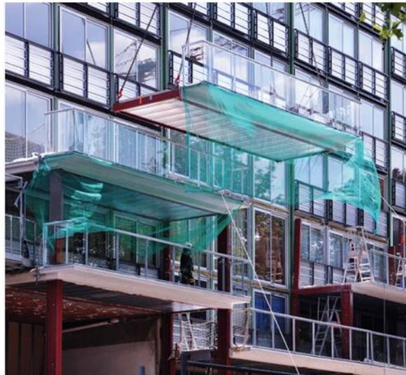
Fig. 30 Montage des extensions de la Tour Bois le Prêtre
