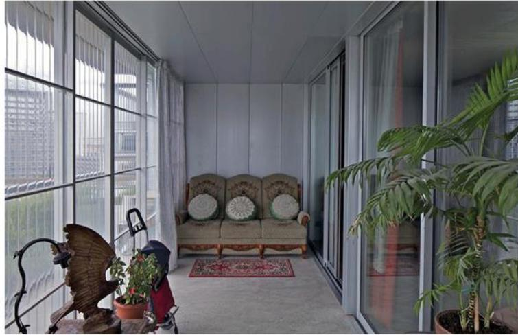
Fig. 45 Jardin d'hiver de la Tour Bois le Prêtre (de gauche à droite : balcon extérieur, polycarbonate coulissant, rideau thermique, double vitrage coulissant, rideau thermique intérieur)
