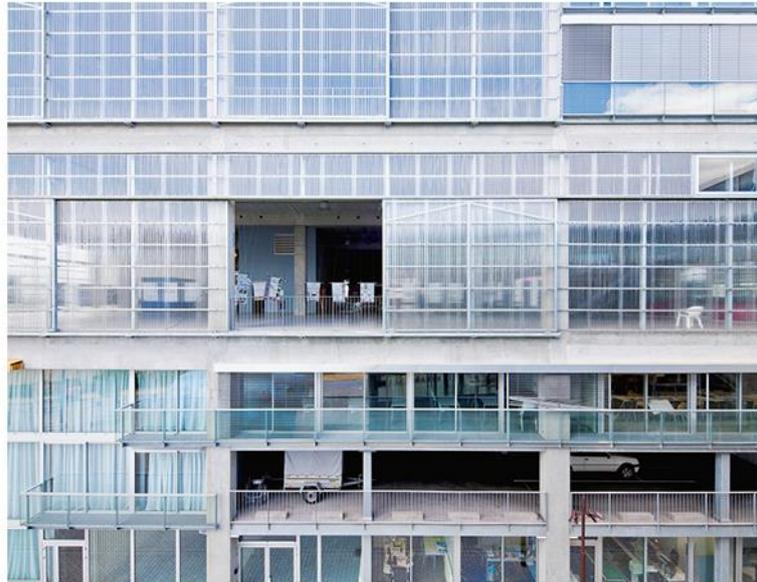
Fig. 47 Façade comprenant les deux systèmes décrits ci-avant. Espaces chauffés en partie inférieure et espaces non chauffés en partie supérieure.
