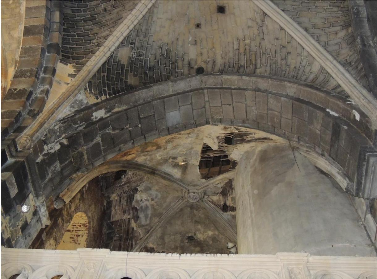
Fig.36 : Voûte dont on peut maintenant observer aisément la matérialité de plâtre et de lattis que lui a substitué Delsaux.
