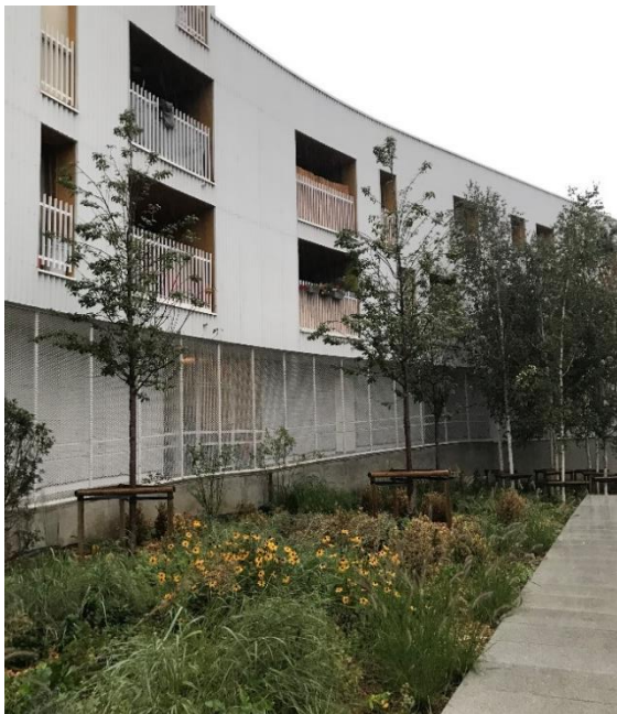
Figure 186: Logements dans le CQD Masui, section 01, regards vers le parc de la Senne. Source: Photo Paulina Quizhpe
