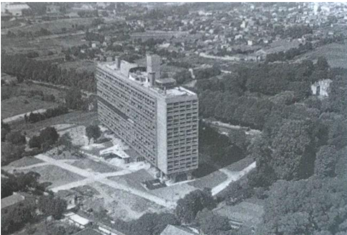
Figure 40: Unité d'habitation. Source: Livre Formes Urbaines: de l'îlot à la barre. Castex J., Depaule J-C., Panerai P., 1997.
