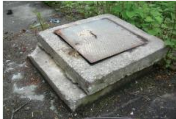
Figure 194: Collecteur d'eaux pluviales. Source: Etude préliminaire: Phase diagnostic: Aménagement du parc de la Senne et sa connexion vers le parc du 21 juillet. Plan transmis par Bruxelles Environnement.
