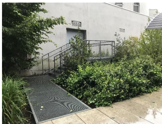
Figure 170: Sortie de secours vers le parc de la Senne, section 01. Source: Photo Paulina Quizhpe
