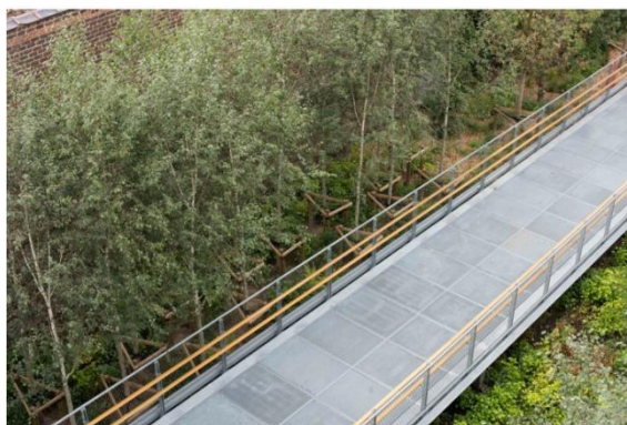
Figure 163: Passerelles en caillebotis métallique. Parc de la Senne. Source: Pyblik, & Artgineering. (2017). « Guide des espaces publics bruxellois ».
