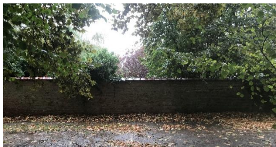
Figure 80: Murets dans le parc Jadot, Ixelles. Source: Photo Paulina Quizhpe
