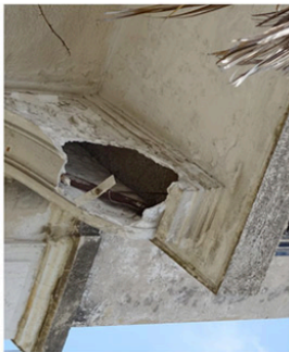
Console à volutes renversées // à reprendre ponctuellement
