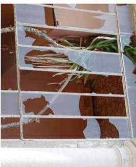
Verrière ancienne acier simple vitrage - montants fins // à retaire à l'identique
