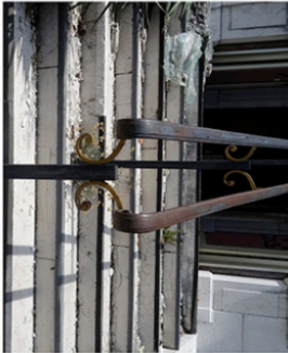
Main courante fer forgé or & noir/ thermoquage // à restaurer
