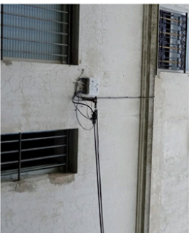
Réseaux électrique façade nord // à démonter
