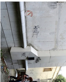
Gaine technique façade nord // à démonter
