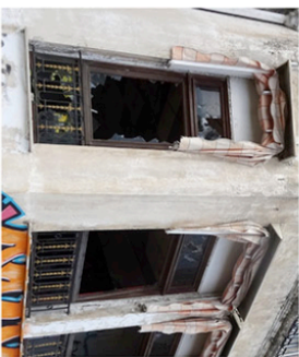
Fenêtre bois d'origine // à retaire à l'identique
