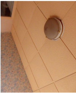
Faux plafond lammes métalliques // à stocker
