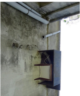
EP et climatisation façade nord // à démonter
