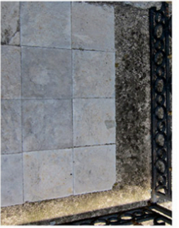
Dalles pierre grises et béton sur balcon // à restaurer
