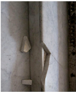
Marbre gris clair, escalier // à conserver
