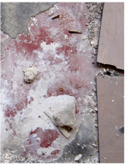
Dalle de sol souple sur béton peint rouge // à curer
