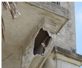
Console à volutes renversées // à reprendre ponctuellement
