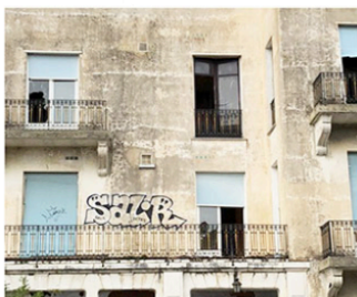
Fenêtre bois, alu, PVC, acier: rénovations successives // à curer
