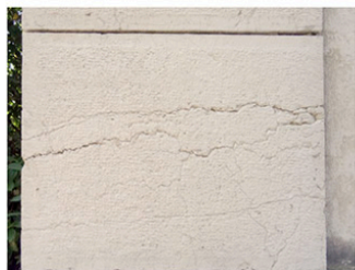
Pierre massive de chaînage Fissurations ponctuelles // à restaurer
