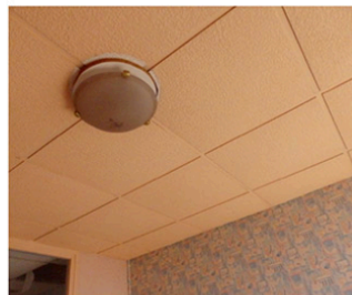
Faux-plafond dalle acoustique // à curer
