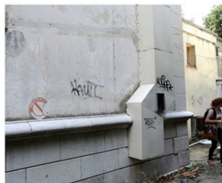
Gaine technique façade nord // à démonter
