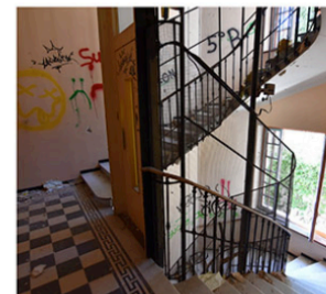
Cage d'escalier grille métallique // à restaurer
