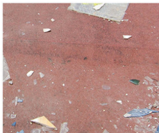
Etanchéité - bitume élastomère // à curer
