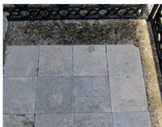
Dalles pierre grises et béton sur balcon // à restaurer
