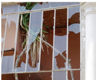
Verrière ancienne acier simple vitrage - montants fins // à refaire à l'identique
