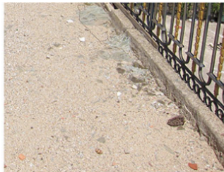
Dalle de béton avec gravier // à curer
