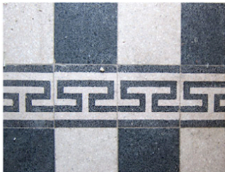
Carreaux granito noir et blanc en damier // à conserver
