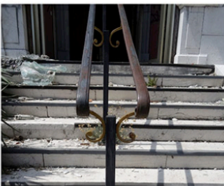
Main courante fer forgé or & noir/ thermolaquage // à restaurer
