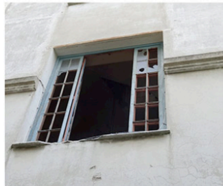
Appui pierre massive à reprendre ponctuellement // à restaurer
