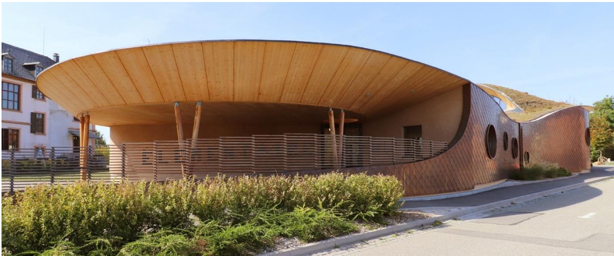
Figure 57 – Photographie de l'école fondamentale de Bernwiller
