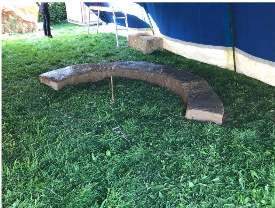
Figure 86 – Construction des fondations de la cabane
