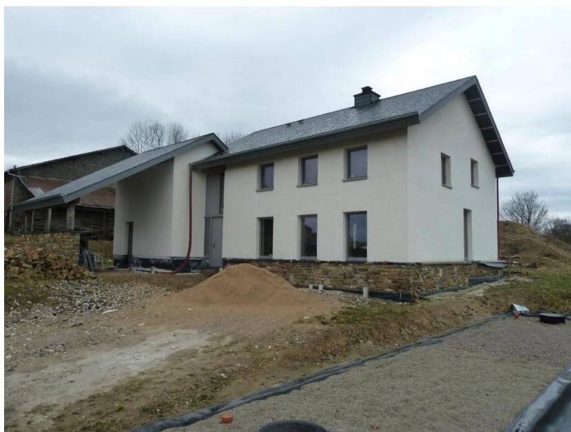
Figure 37 – Photographie du projet Hallet
