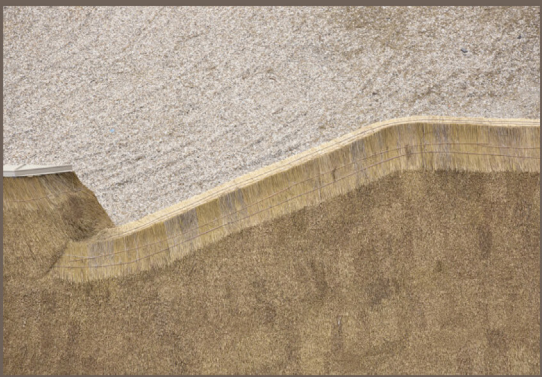
Figure 46. Faîtage en chaume . Chaume urbain de Woonwalk collectif d'architectes . Photo Clément Guillaume
