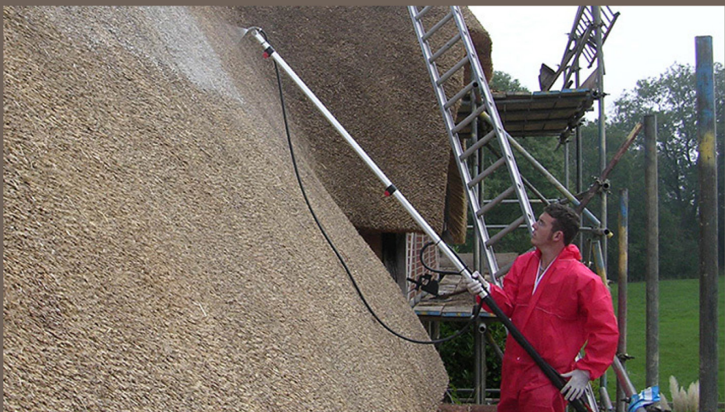
Figure 35. Pulvérisation du produit ignifuge sur toiture en chaume . Crédit Magma Firestop
