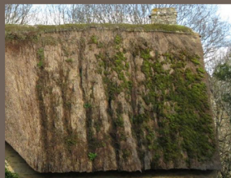
Figure 34. Dégradations diverses de toitures en chaume . Crédit Parc naturel régional de Brière
