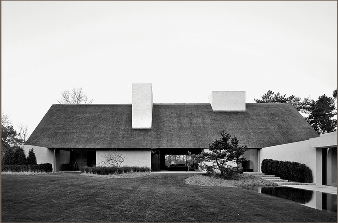
Figure 4. VO Residence, Knokke . Architecte Vincent Van Duysen . Knokke, Belgique Photo H el ene Binet
