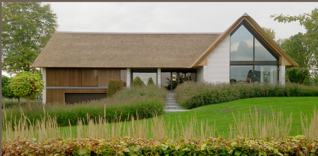
Figure 96. Transformation de toiture d'une habitation unifamiliale . Crédit Tom Jonckers
