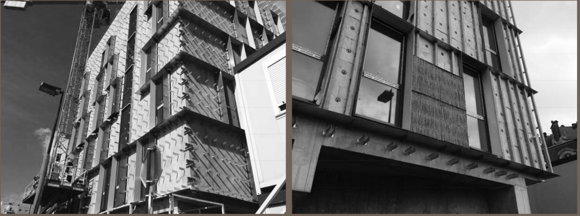
Figure 83. Mise en oeuvre des panneaux de façade . Nantes . Crédit Forma 6
