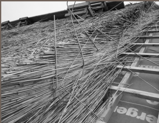
Figure 90. La mise en oeuvre du chaume . Crédit CoBe
