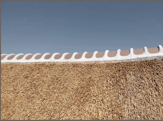
Figure 42. Faîtage en tuiles . Crédit artisans chaumiers Bougeard
