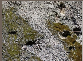
Figure 34. Dégradations diverses de toitures en chaume . Crédit Parc naturel régional de Brière
