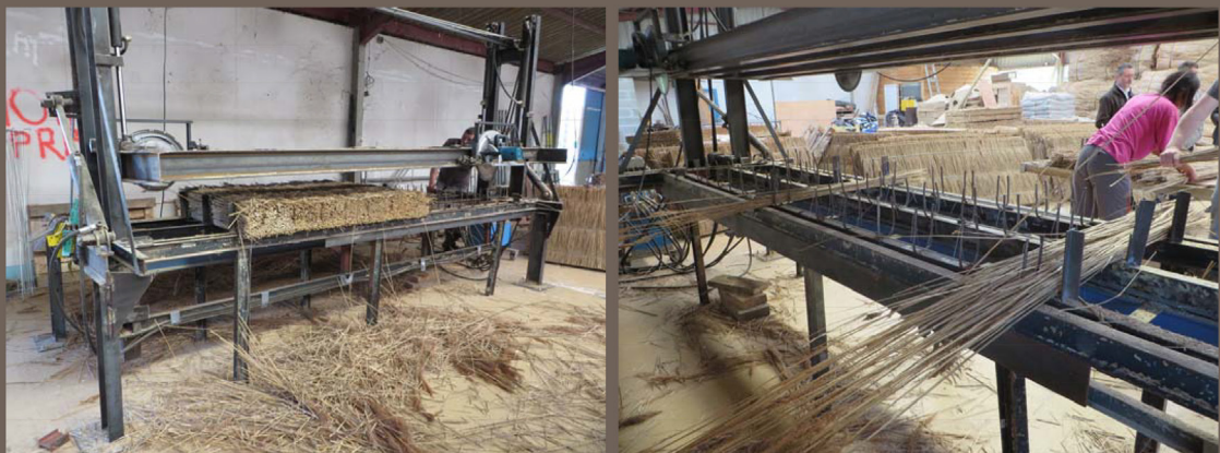
Figure 82. Processus de préfabrication des panneaux de façade . Nantes . Forma 6 . Crédit forma 6
