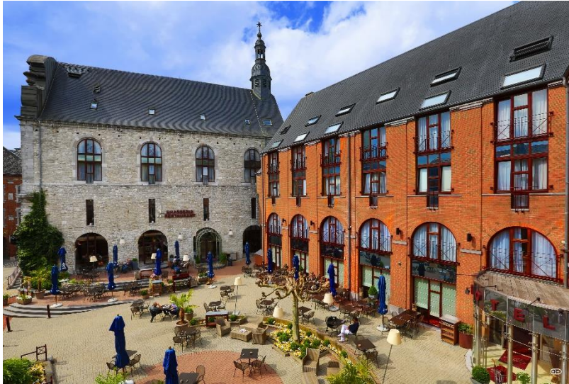
Figure 18 - L'ancienne église jésuite de Marche-en-Famenne est aujourd'hui occupée par le complexe hôtelier du Quartier Latin
