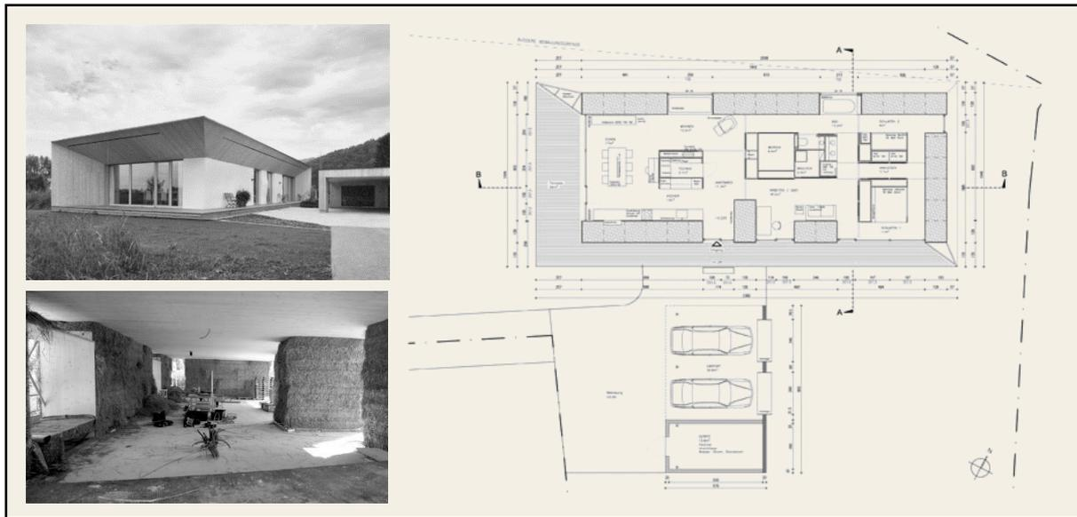
Il s'agit d'une maison individuelle autrichienne construite en 2014. La paille joue un rôle complet avec de **grands ballots porteurs de 2,50 x 1,20 x 0,75m qui serviront** à la fois de support aux enduits et d'isolant.
