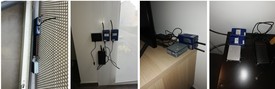
FIGURE 7.5 – Photos du positionnement des capteurs : de gauche à droite, point extérieur, point 1, point 2 et point 3
