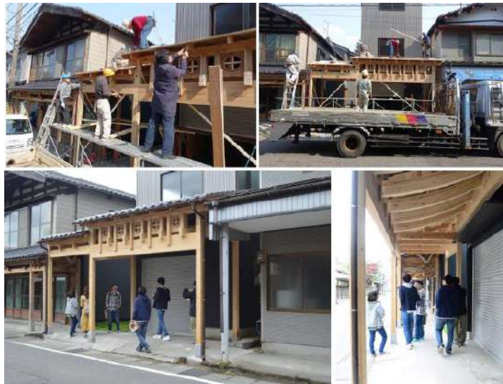
Figure 20 : Construction Gangi réalisée en avril 2017 (Nishimura, Boda, & Sakurai, 2017)
