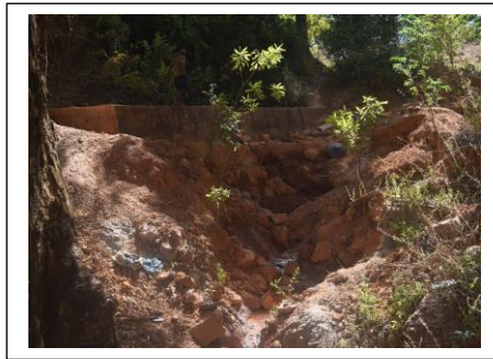
Figure 27 Barrage pour dévier les cours d'eau
