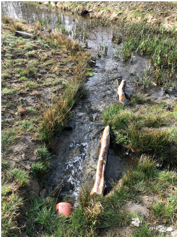
Figure 8 : Prise d'eau de l'étang amont lors de la campagne de mesure de débit.
