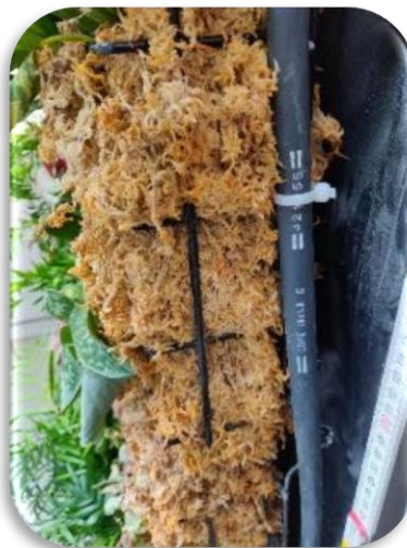
Figure 24: Coupe latérale d'un mur végétal intérieur avec substrat sphaigne
