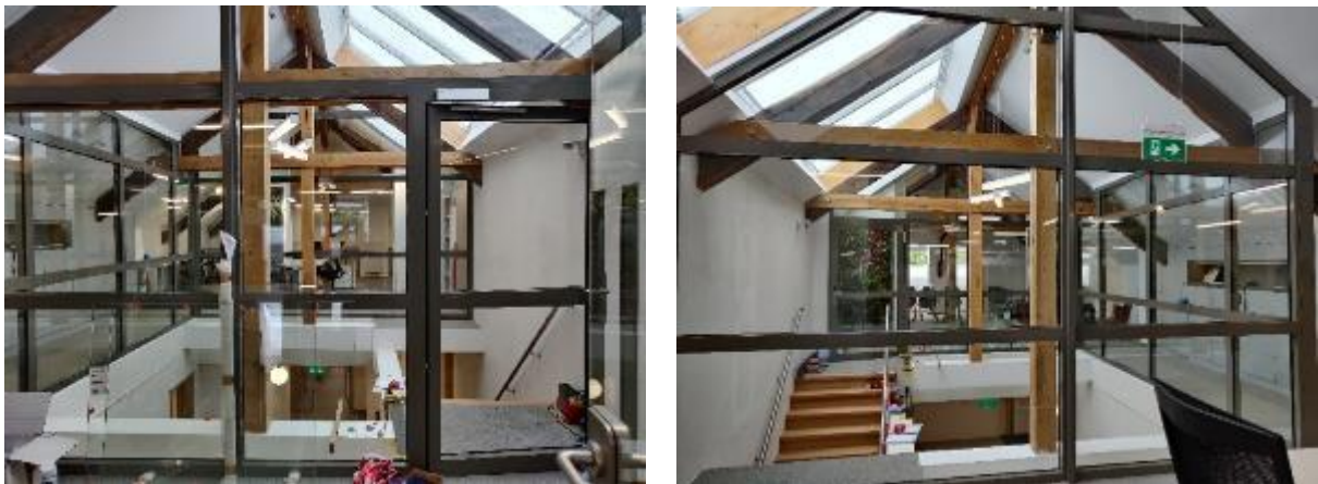
Figure 19: Verrière- vue ouest à gauche et vue est à droite - 3 ème étage
