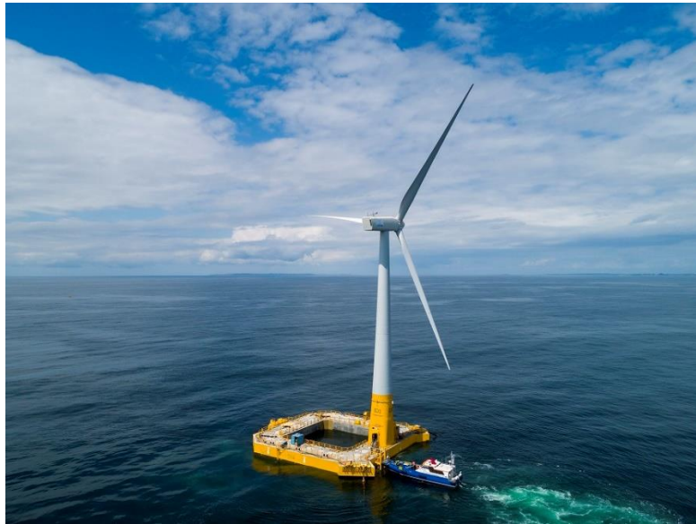
Figure 2.5 BW Ideol – Floatgen
