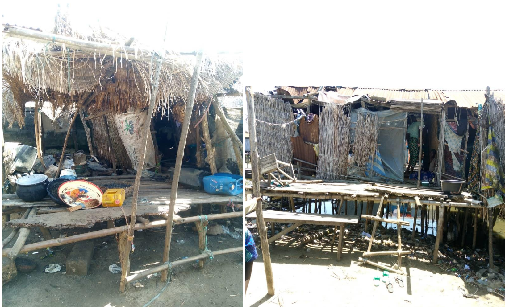
Photo 3: Habitations de PH dans la commune de Sô-ava (Source : GNIMASSOU, 2021)
