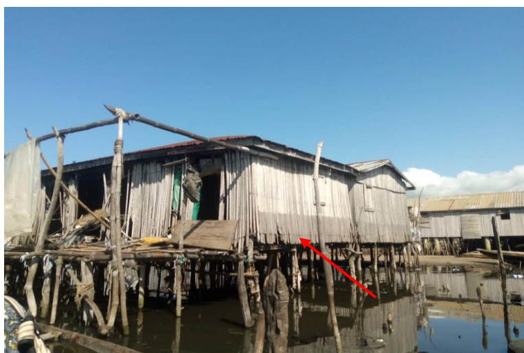
Photo 5: Niveau de l'eau pendant les inondations ( source : GNIMASSOU, 2021 )
