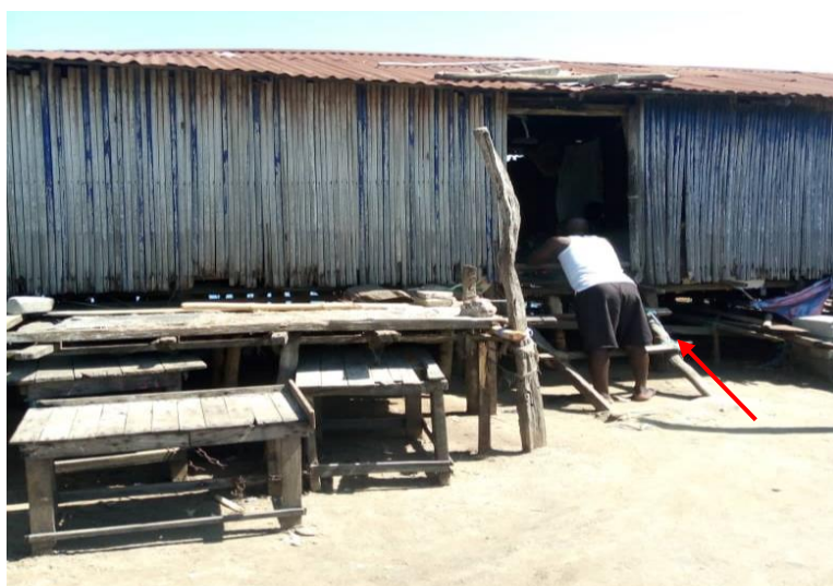
Photo 6: L'entrée inadéquate de chambre d'une PH (source : GNIMASSOU, 2021)
