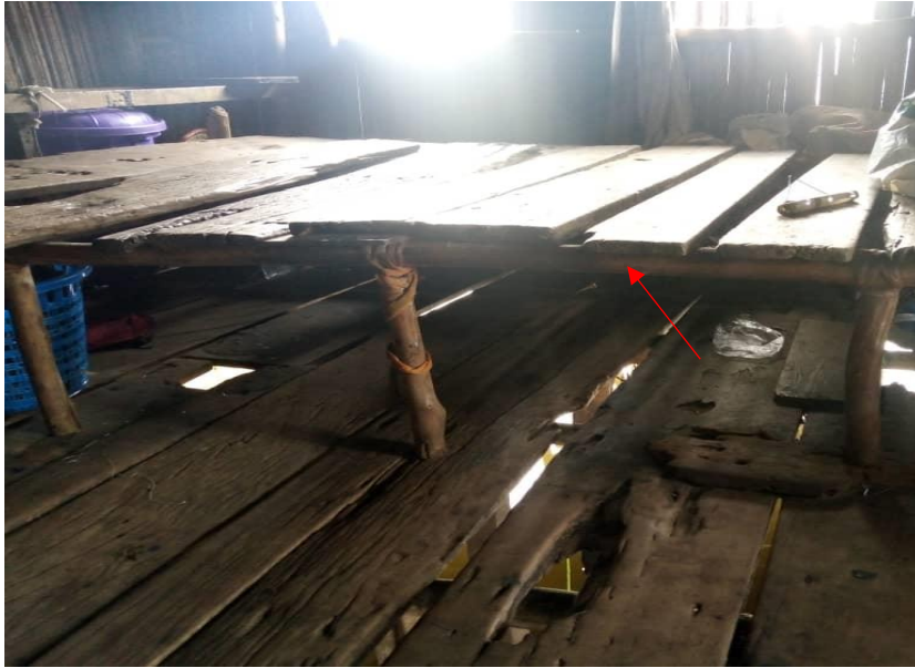
Photo 4: Chambre rehaussée avec la fabrication de chalet de bois sur pilotis (source : GNIMASSOU, 2021)
