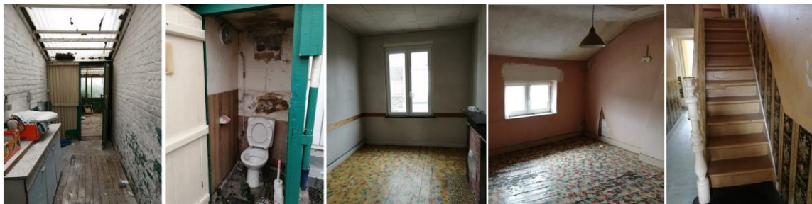
Figure 7-2 : De gauche à droite – espace de cuisine vétuste dans la véranda, w.c. extérieurs vétustes, chambre à transformer en salle de bain, chambre avec éclairage naturel insuffisant, escalier à conserver et éventuellement rafraichir.
