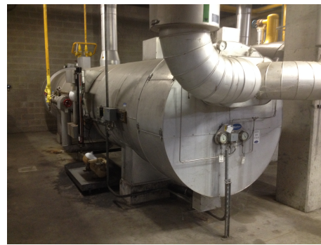
FIGURE 18 – Evaporateur pour l'eau glycolée
