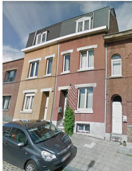
Figure 3-2 : Photo de la façade avant de l'habitation (briques rouges)
