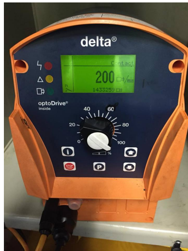
FIGURE 6.1 – Pompe doseuse à membrane assurant l'apport en Lubranol DWS 3G sur les groupes 1 et 3 - ABI Jupille
