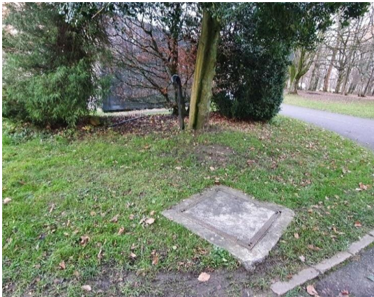
Figure 18: citerne enterrée du campus
