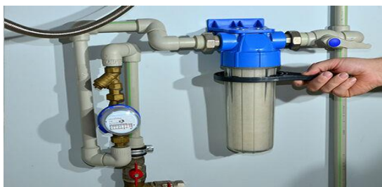
Figure 10: Filtre interne « micro-filtre » source : solyd.be
