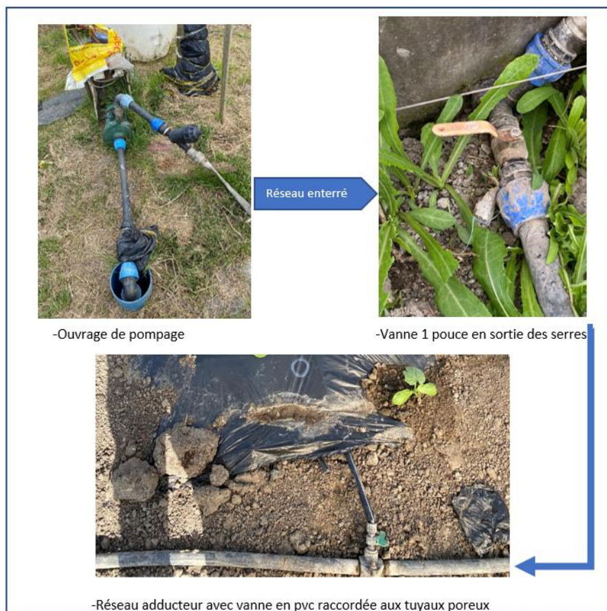
Figure 16 : Schéma illustré du fonctionnement du goutte à goutte dans les serres de la ferme
