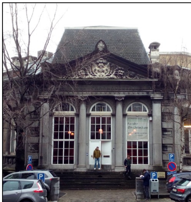
Fig.57 : Aspect général de la façade 0/03, photographie personnelle, 16/02/2018.
