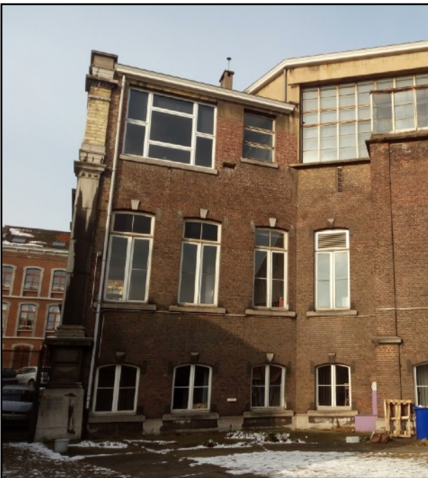
Fig.50 : Rehaussement de la façade 0/00, (1935-1939), photographie personnelle prise le 13/09/2021.
