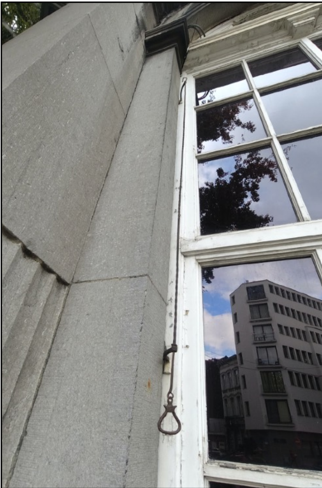
Fig.31: Dispositif de sonnette situé sur l'entrée principale de l'institut (0/03), juste à côté de la maison du concierge, photographie personnelle, 05/10/2021.
