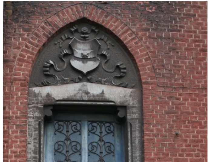
Fig.68 : Caractère ouvragé de la façade de la maison directoriale de l'Observatoire de Cointe, photographie personnelle, 14/02/2020.
