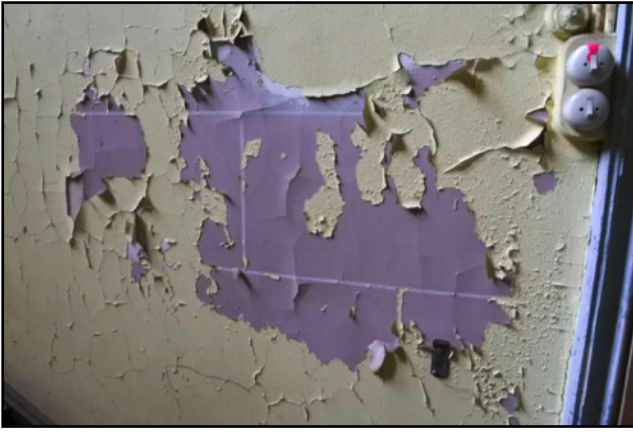
Fig. 29 : Faux-appareil sur enduit, dans la maison directoriale de l'Observatoire, photographie personnelle, prise le 14/02/2020.
