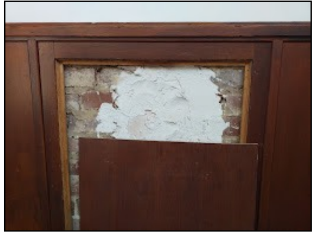
Fig.48 : Arrière d'un lambris, ne présentant pas de trace de parachèvements (1/4C), photographie personnelle prise le 13/09/2021.
