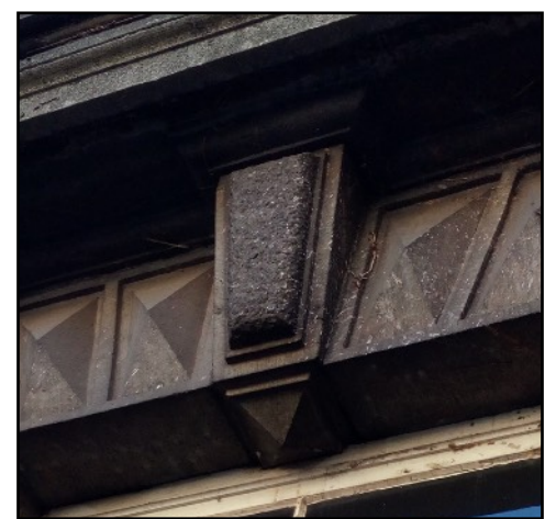
Fig.64 : Taille bouchardée d'une l'agrafe (0/06), photographie personnelle, 08/10/2021.
