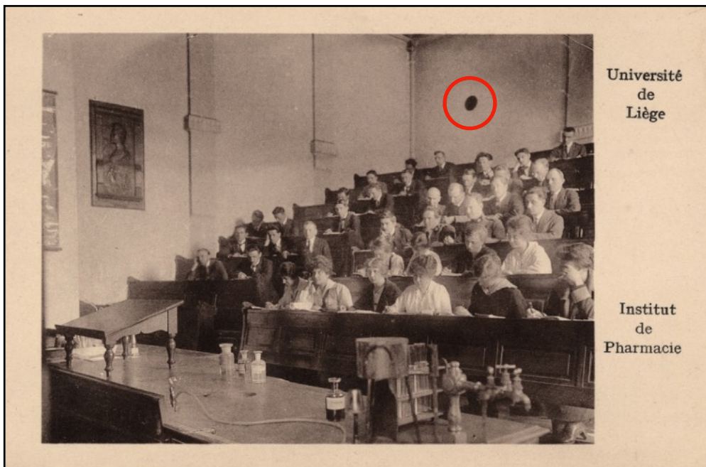
Fig.75 : Mise en évidence d'une grille d'aération. D'après une photographie de l'auditoire, par Gustave Marissaux, 1921 (?).
