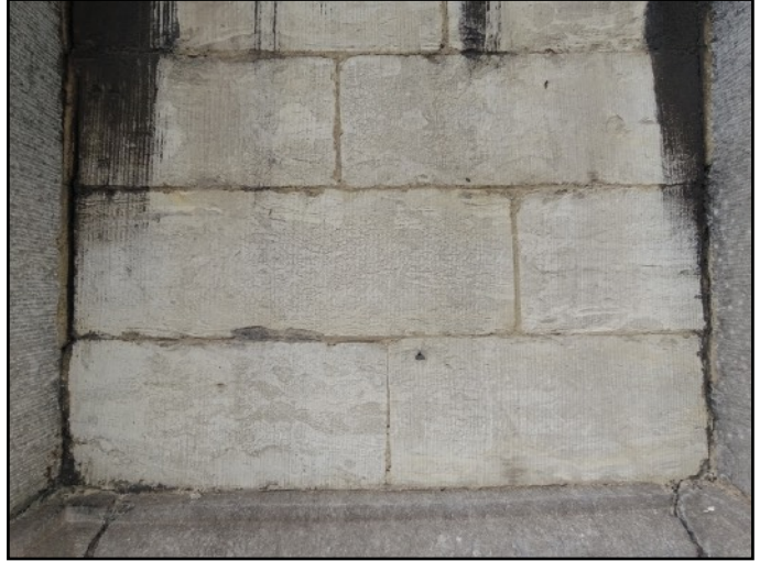
Fig.66 : Appareillage de la pierre de Gobertange (0/02), photographie personnelle, 08/10/2021.
