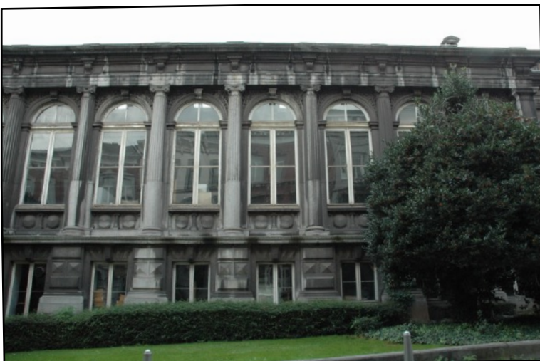
Fig.61 : Avant-corps du laboratoire (0/05), photographie personnelle, le 08/10/2021.
