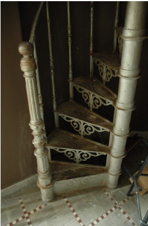
Fig.40 : Escalier hélicoïdal métallique du local 1/9, photographie personnelle prise le 08/10/2021.
