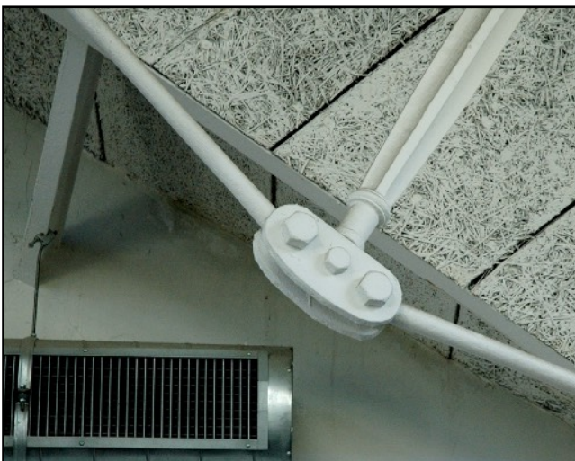
Fig. 88 : Plaques d'attache de l'assemblage des barres d'un arêtier (sans entrain), photographie personnelle, 06/10/2021.
