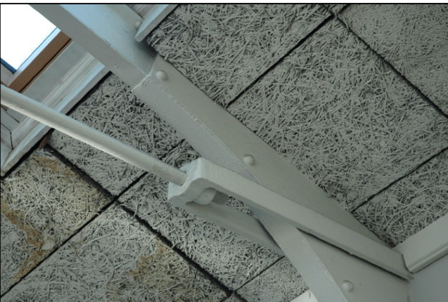
Fig.84 : Fourche d'une corde de traction allant rejoindre un sabot, au pied d'une des fermes du grand laboratoire, photographie personnelle, 06/10/2021.
