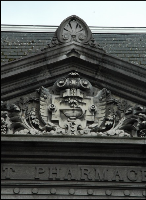
Fig.65 : Différence de teinte de la pierre employée pour le fronton (0/03), photographie personnelle, 08/10/2021.
