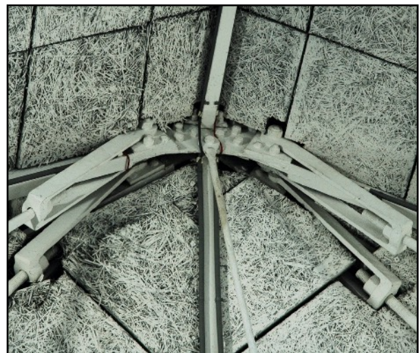
Fig. 89 : Plaque d'attache simple au faite d'un arêtier, photographie personnelle, 06/10/2021.
