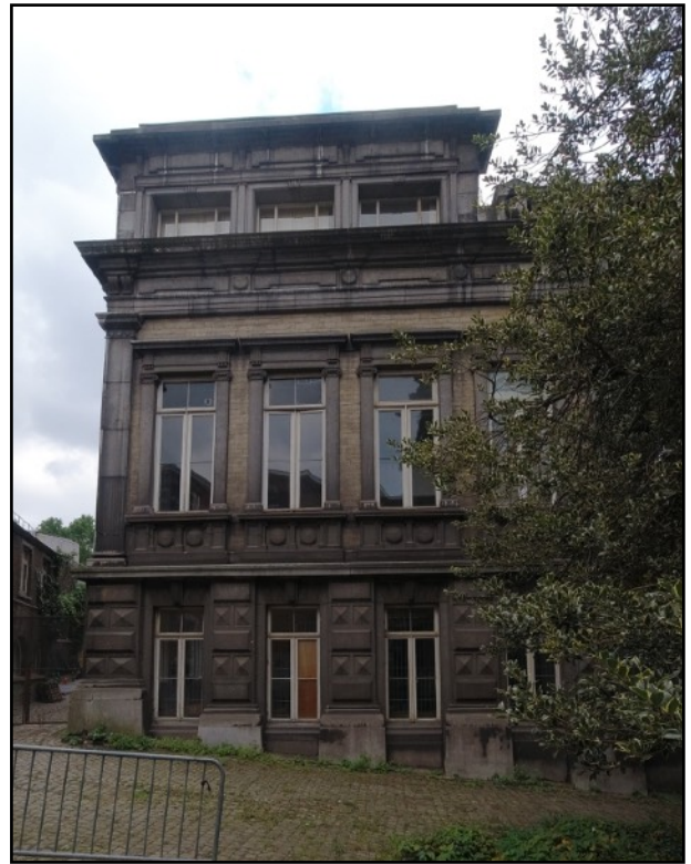
Fig.51 : Rehaussement du pignon 0/07 (vers 1937), photographie personnelle prise le 13/09/2021.
