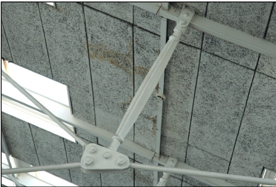
Fig. 80 : Bielle d'une des fermes du grand laboratoire, photographie personnelle, 06/10/2021.
