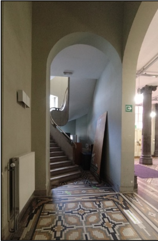
Fig.38 : Escalier en granito installé en 1935-1939, dans la nouvelle travée (0/10), photographie prise le 06/05/2021.
