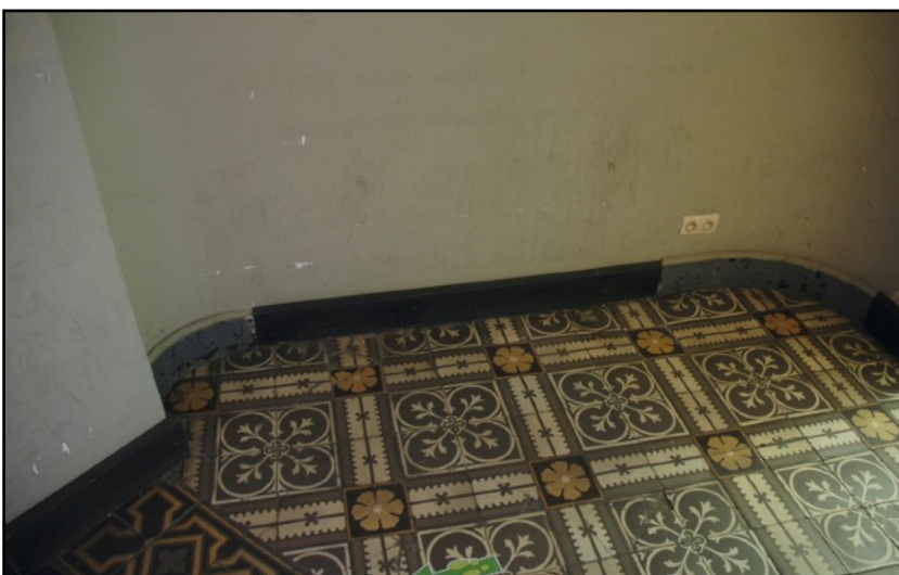
Fig.34 : Emplacement de l'ancienne entrée de la maison du concierge (0/20), vérifié par sondage sonore, photographie prise le 08/10/2021.
