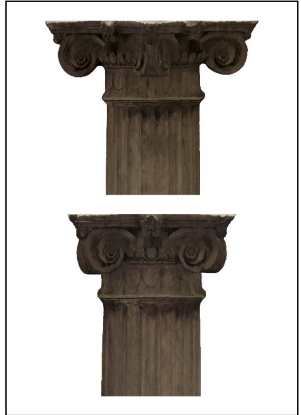
Fig. 30: Ornementation du chapiteau ionique d'une des colonnes du péristyle (0/1), élévations d'après une photogrammétrie, générée le 08/10/2020.
