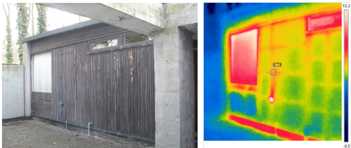
Figure 47 -Photographie thermique extérieure n°7
