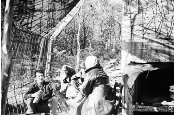
Figure 69 : Chantier de l'habitation-sculpture, 1967.
