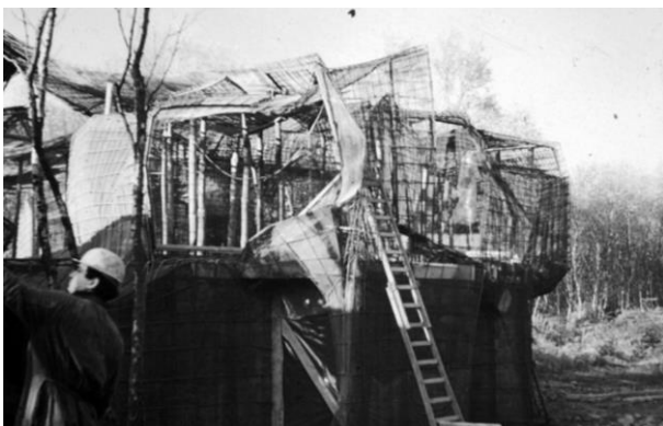
Figure 68 : Vue d'ensemble du chantier.
