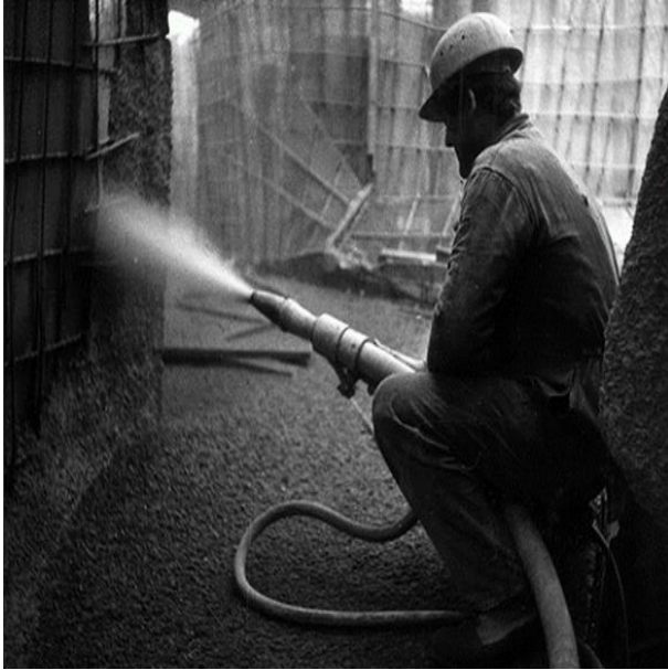
Figure 24 : Phase de gunitage, Ouvriers de l'entreprise Pasek projetant le béton.
