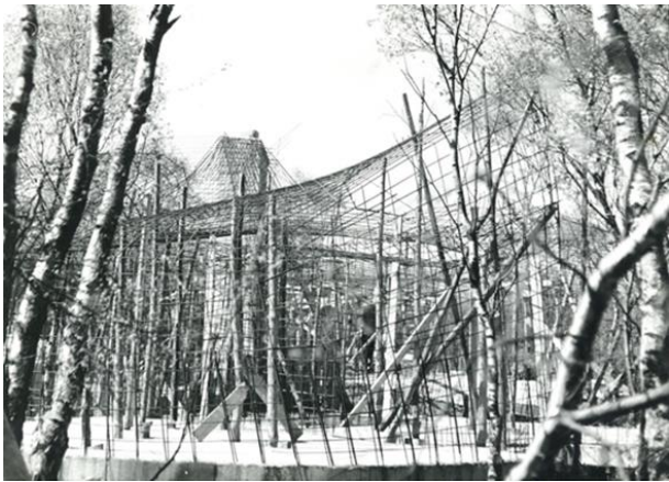
Figure 4 : Les cheminées, deux points d'accroche et les renforts de rive.
