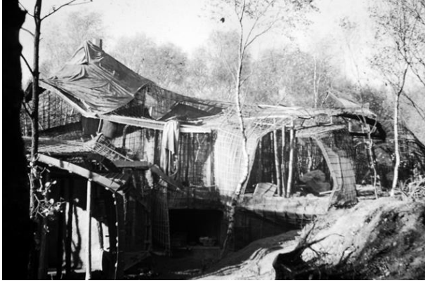
Figure 49 : Vue d'ensemble du chantier avant le gunitage.
