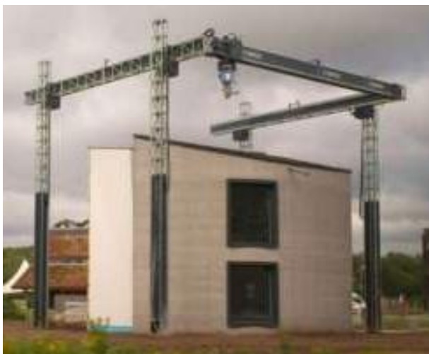
Figure 70 : COBOD, Premier bâtiment de deux étages imprimé en 3D en Europe, Belgique,, 2020.
