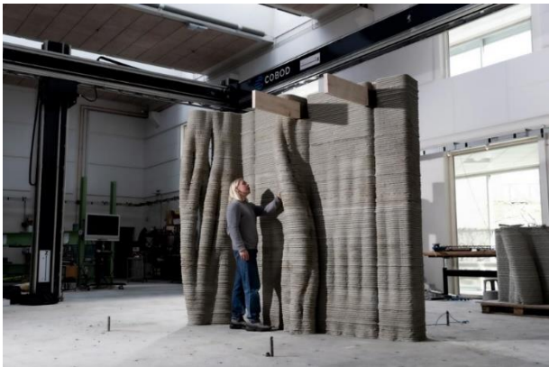
Figure 87 : Adrian Rygh Brun, mur imprimé en 3D, 2020.
