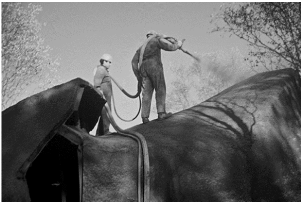
Figure 23 : Phase de gunitage, Ouvriers de l'entreprise Pasek projetant le béton.
