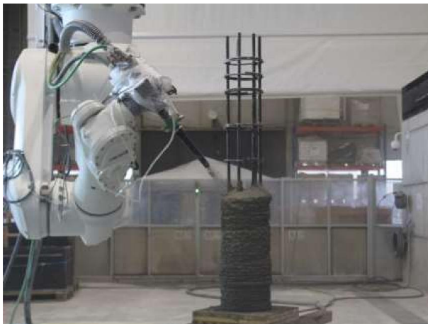
Figure 60 : TU Braunschweig, Production des premières colonnes en béton armé par impression 3D, 2019.
