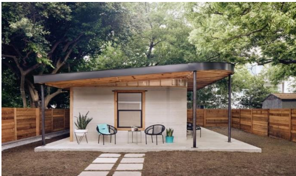
Figure 12 : Icon, Maisons imprimées en 3D en 24 heures à Austin, Texas, 2018.
