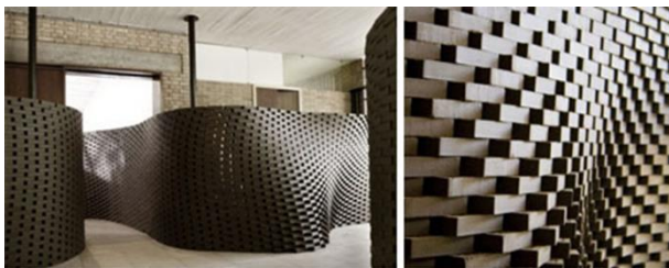
Figure 29 : Gramazio & Kohler, Façades en briques non-standard, ETH Zurich, 2006.
