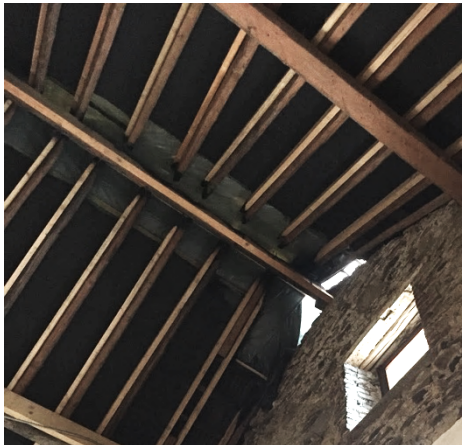
Figure 60: Vue de la charpente depuis le corps de logis après l'incendie (Manon Vandersmissen, 2021).
