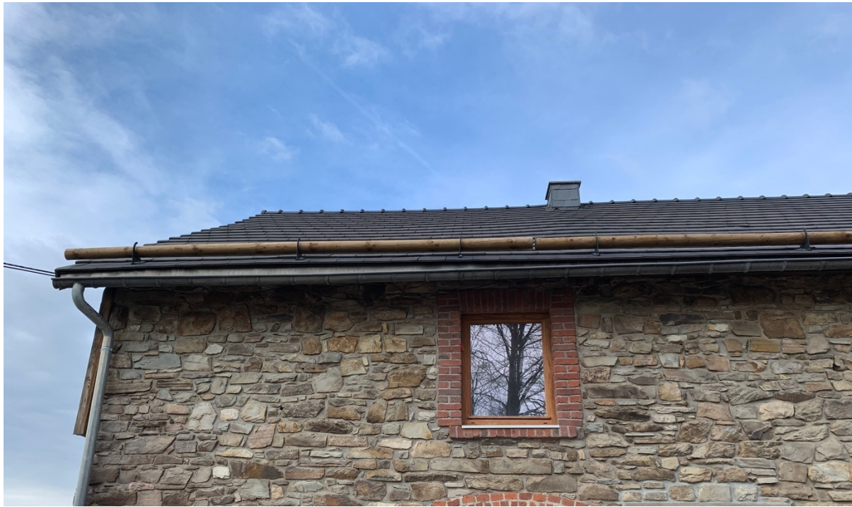
Figure 20: Bon sens, présence d'une protection pour éviter les chutes de neige, ferme à Robertville (Manon Vandersmissen, 2022).
