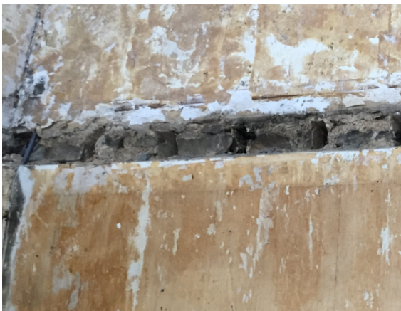
Figure 82: État du mur après suppression des anciens planchers (Manon Vandersmissen, 2021).
