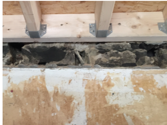
Figure 82: État du mur après suppression des anciens planchers (Manon Vandersmissen, 2021).
