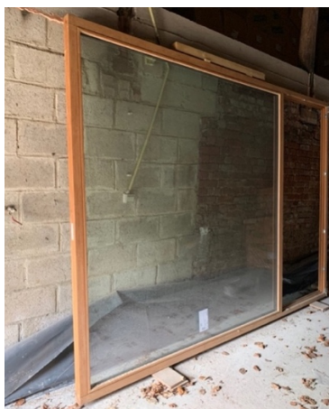
Figure 91: Châssis en afzelia pour la nouvelle ouverture en façade arrière (Manon Vandersmissen, 2022).
