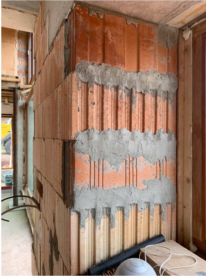
Figure 103: Expérimentation du mono-mur en bloc de terre cuite, Xhoffraix (Manon Vandersmissen, 2022).
