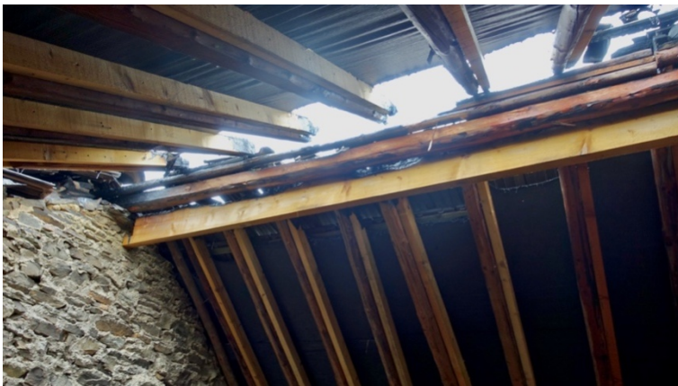
Figure 63: Dégâts sur la charpente après l'incendie (Norbert Nelles, 2021).
