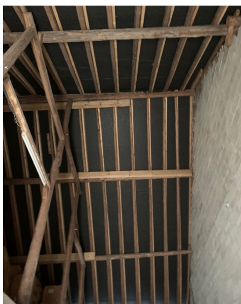
Figure 64: Charpente de toiture après réparation et dédoublement (Manon Vandersmissen, 2022).
