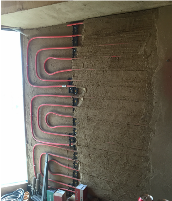
Figure 92: Exposition d'enduit mural en argile avec intégration de tuyaux de chauffage, Waimes (Manon Vandersmissen, 2021).
