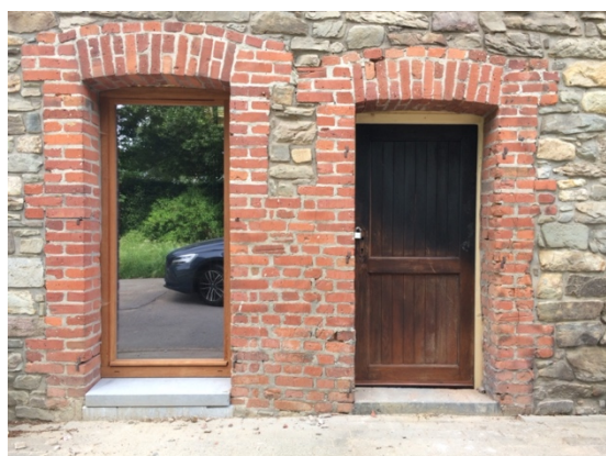
Figure 87: Fenêtre avant remplacement du linteau (Norbert Nelles, 2022).
