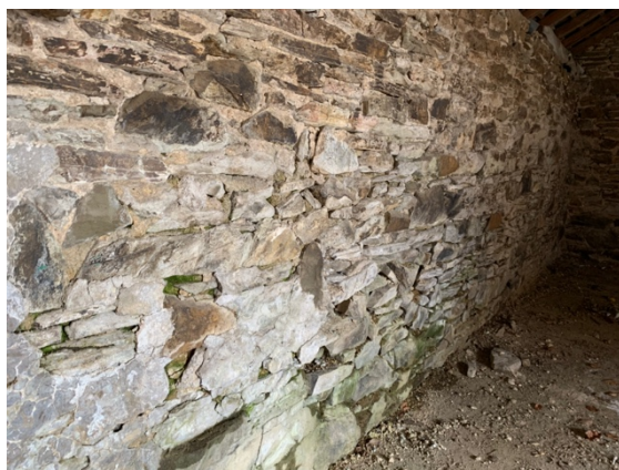
Figure 95: État actuel du mur de soutènement de l'auvent (Manon Vandersmissen, 2022).
