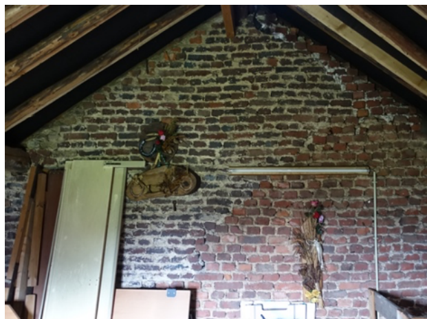
Figure 50: Marque visible sur le mur attestant des transformations et des agrandissements au cours du temps (Norbert Nelles, 2021).
