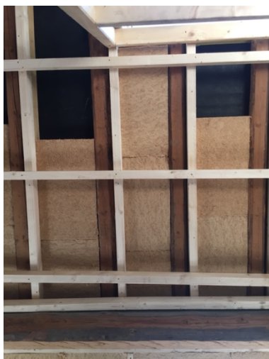
Figure 67: Mise en place de l'ossature en épicea (Manon Vandersmissen, 2021).
