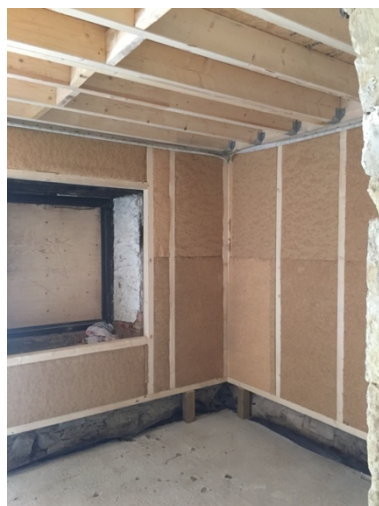
Figure 67: Mise en place de l'ossature en épicea (Manon Vandersmissen, 2021).
