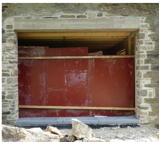
Figure 89: Création d'une nouvelle baie en façade arrière (Norbert Nelles, 2022).
