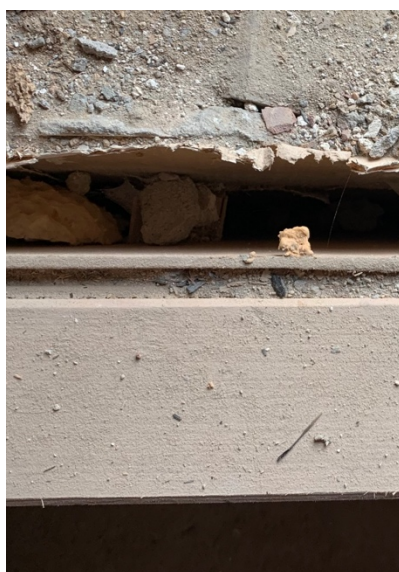
Figure 71: vide entre le mur de maçonnerie et la nouvelle cloison en épiceas (Manon Vandersmissen, 2022).
