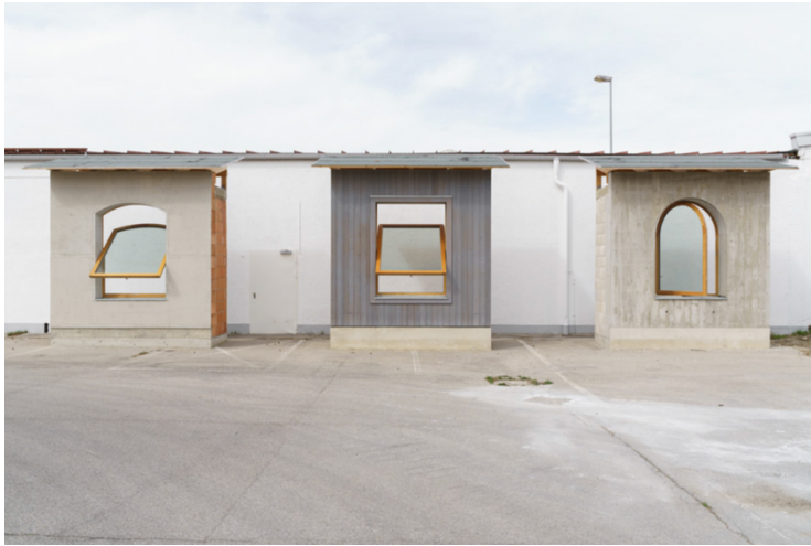
Figure 23: Expérimentation des trois matériaux de maçonnerie pour le projet Bad Aibling (Nagler, 2020).
