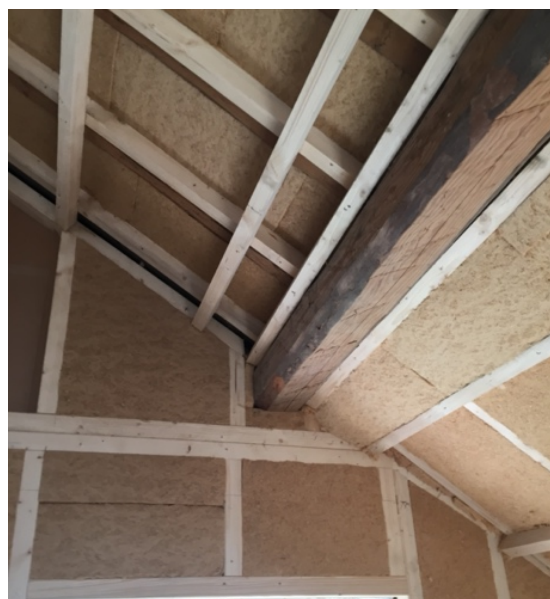
Figure 64: Charpente de toiture après réparation et dédoublement (Manon Vandersmissen, 2022).
