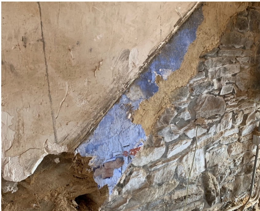
Figure 93: Trace de l'ancien enduit à la chaux de teinte bleutée (Manon Vandersmissen, 2022).
