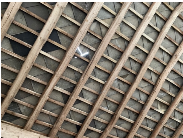
Figure 97: Recouvrement actuel en asbeste (Manon Vandersmissen, 2022).
