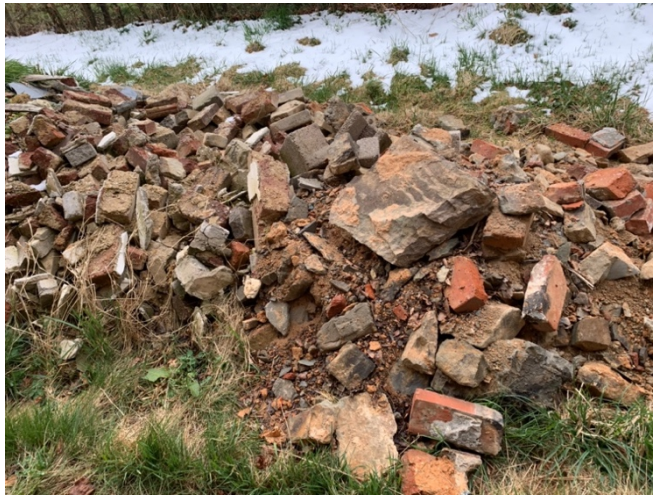
Figure 80: Morceaux de briques conservés sur le chantier pour de la réutilisation (Manon Vandersmissen, 2022).
