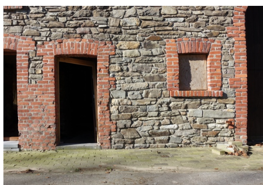
Figure 84: Fenêtre avant transformation en porte (Norbert Nelles, 2022).
