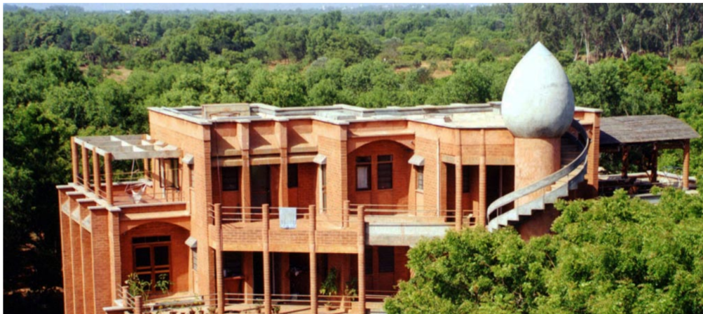
FIGURE 2.20 – Maison construite en BTC stabilisée à hauteur de 5% de ciment [33]
