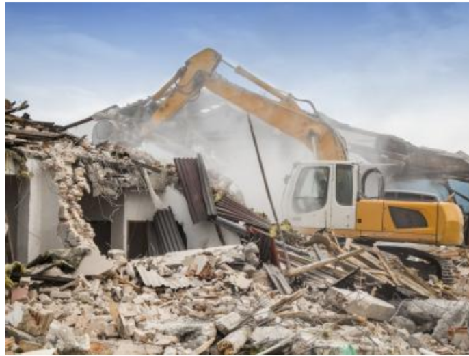
FIGURE 1.2 – Déchets de démolition [5]
