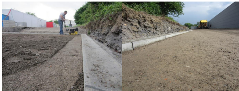
FIGURE 2.7 – Fondation de voirie grâce aux granulats recyclés [10]
