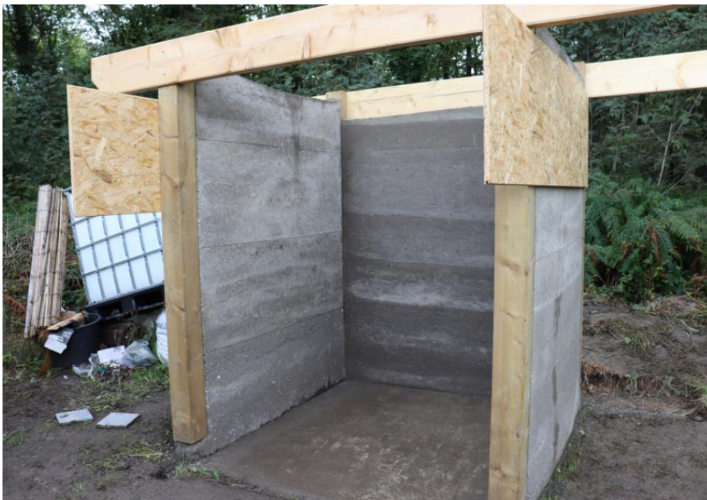
FIGURE 2.10 – Murs en béton damé recyclé du PotIngé [12]
