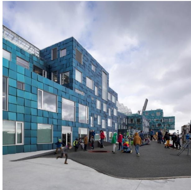
Façade photovoltaïque à l'école internationale de Copenhague Source : ArchDaily, 2018
