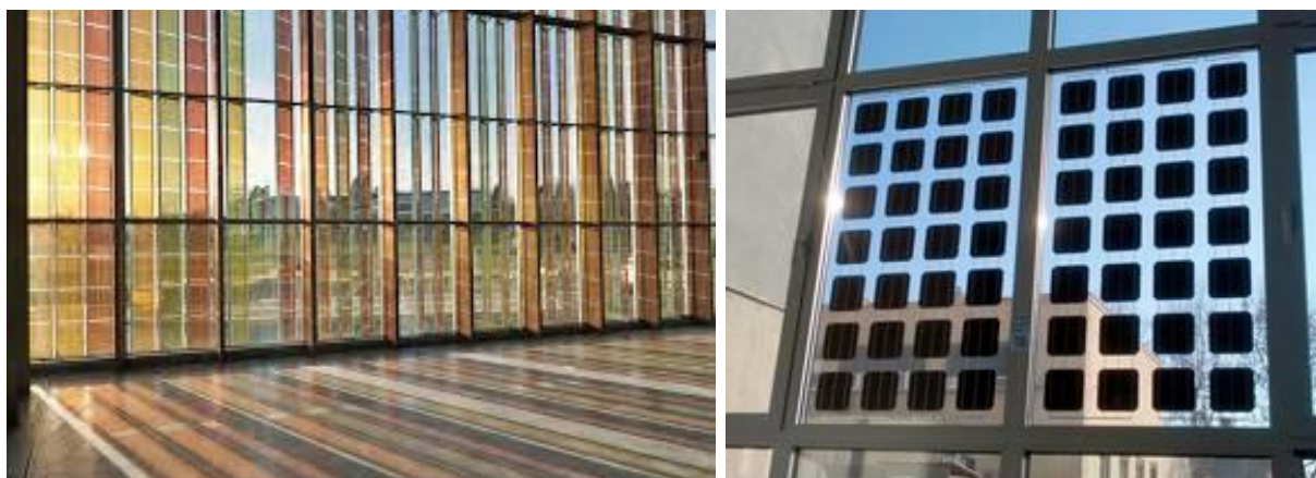
Figure 17: À gauche : Vitrage solaire coloré du SwissTech Convention Center. Source : Solaronix, 2022 À droite : Fenêtre à cellules solaires opaques espacées. Source : LPVO, 2019
