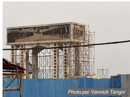
Figure 8 : Rénovation de la porte du Non-Retour à Ouidah
