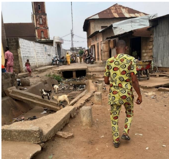
Figure 92 : Etat des canaux à la période de Janvier 2022
