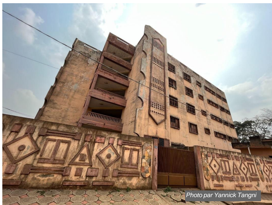
Figure 71 : Immeubles à 4 étages jouxtant la place Djissou- Gbogan
