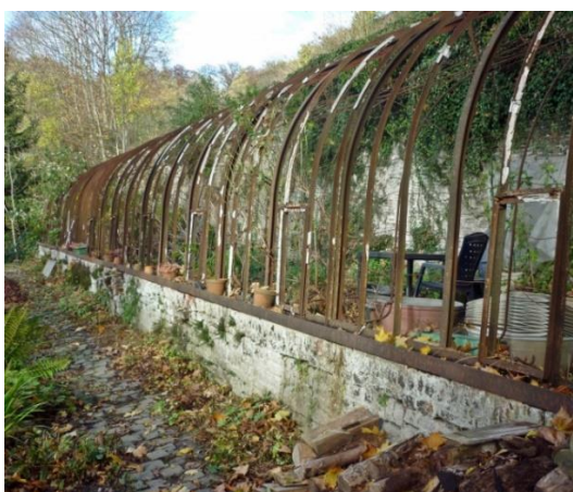
Figure 3 - Serres du parc Quatre-Heures, Spa (DGO4, s.d.)
